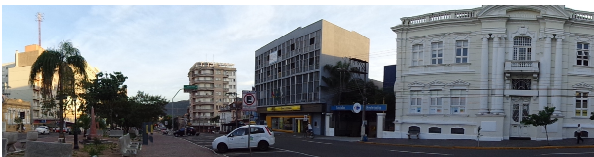
Figura 68 – Avenida Rio Branco, à direita em destaque o prédio onde funcionou a Escola Industrial de Artes e Ofícios, e o último prédio logo abaixo, o Edifício Mayer. Fonte: Neida M. C. Freitas/2013.
