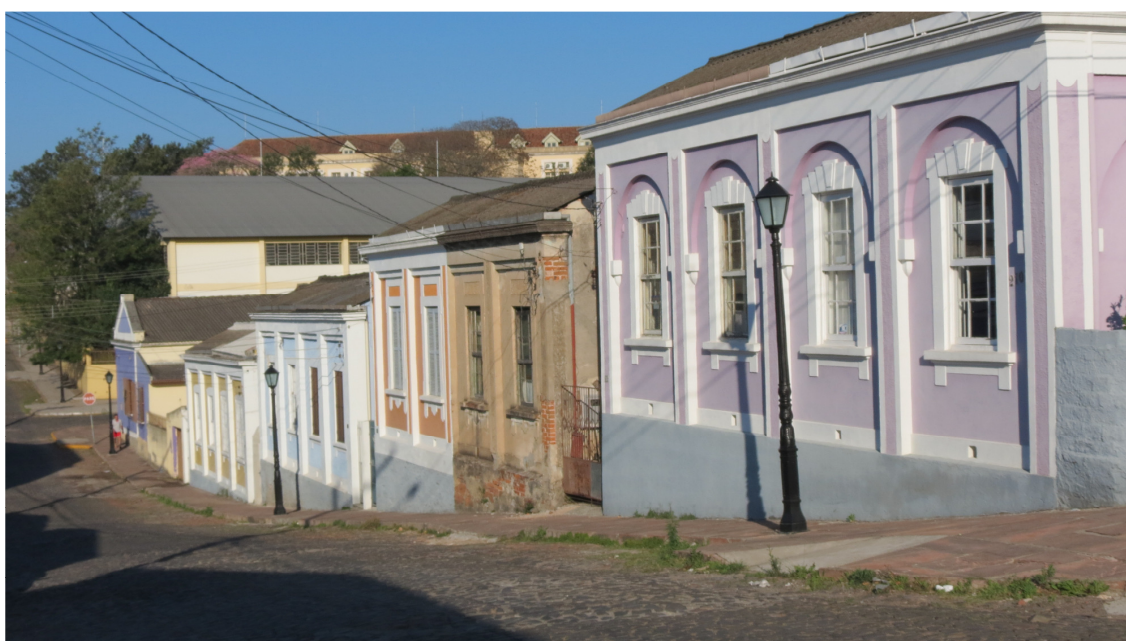
Figura 70 – Vila Belga – Rua Ernesto Becker quase esquina com a Rua André Marques. Fonte: Neida M. C. Freitas/2013.
