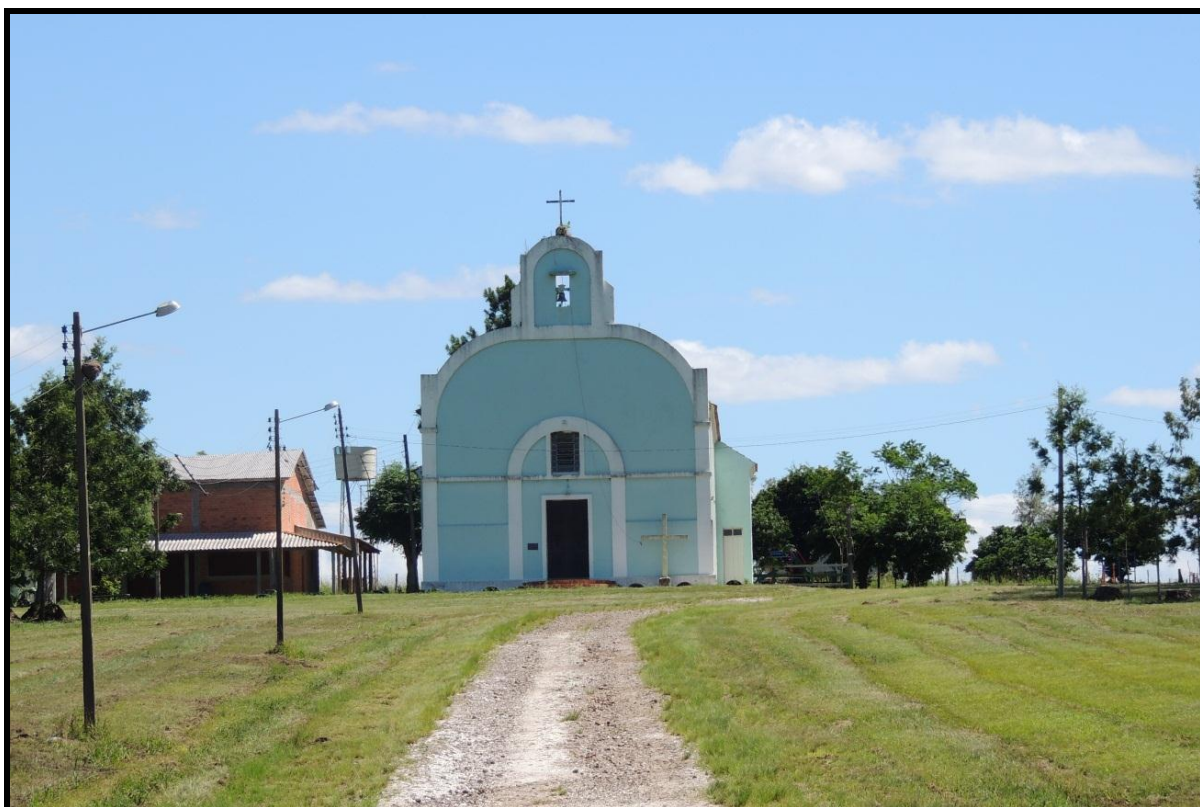
Figura 3: Igreja Santa Flora localizada no distrito de Santa Flora. Fonte: Trabalho de campo, 2014.
