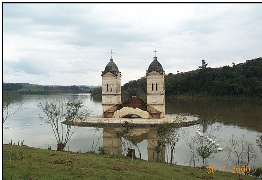
FIGURA 9: Ruínas das torres da Igreja de São Pedro da cidade velha FONTE: http://nutep.adm.ufrgs.br/fostosmuni/fotossantacatarina.htm
