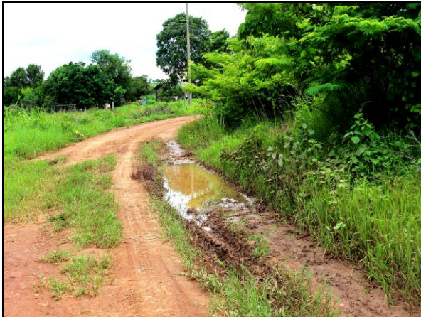
Figura 18 – Fotografia das condições precárias das vias de acesso ao assentamento Zumbi dos Palmares
