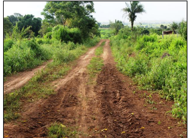
Figura 19 – Fotografia das condições precárias das vias de acesso ao assentamento Zumbi dos Palmares
