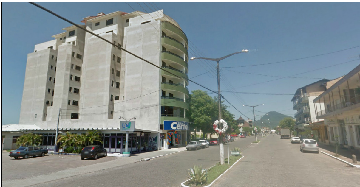
Figura 15 – Prédio com nove pavimentos, Av. Concórdia – Agudo/RS (ao fundo, em direção oeste, o Morro Agudo, que dá nome à cidade). Fonte: Trabalho de campo (2014).
