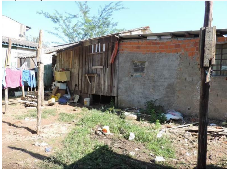
Figura 11 - Fotografia da moradia 50, residência localizada na margem do rio Vacacaí Mirim, com baixo padrão construtivo e presença de lixo.
