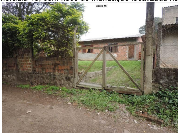
Figura 19 - Fotografia da moradia 46, com risco de inundação localizada na rua Atílio Munari.
