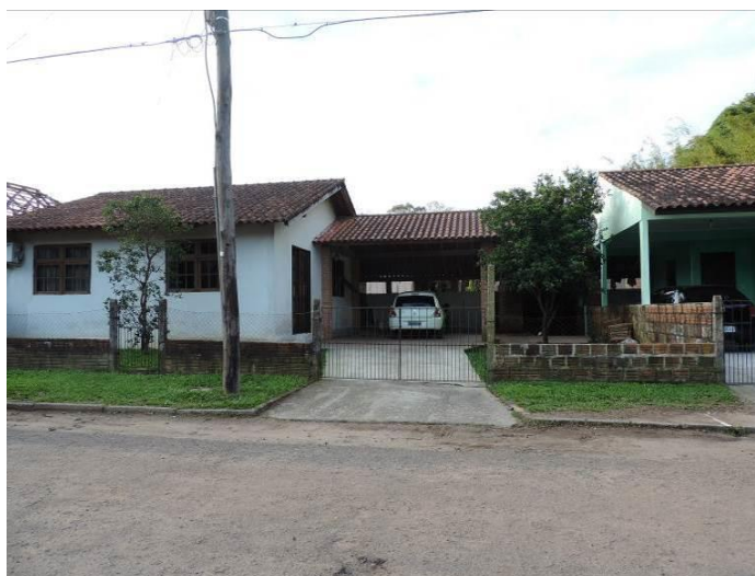
Figura 27 - Fotografia da moradia 02A com histórico de inundação.
