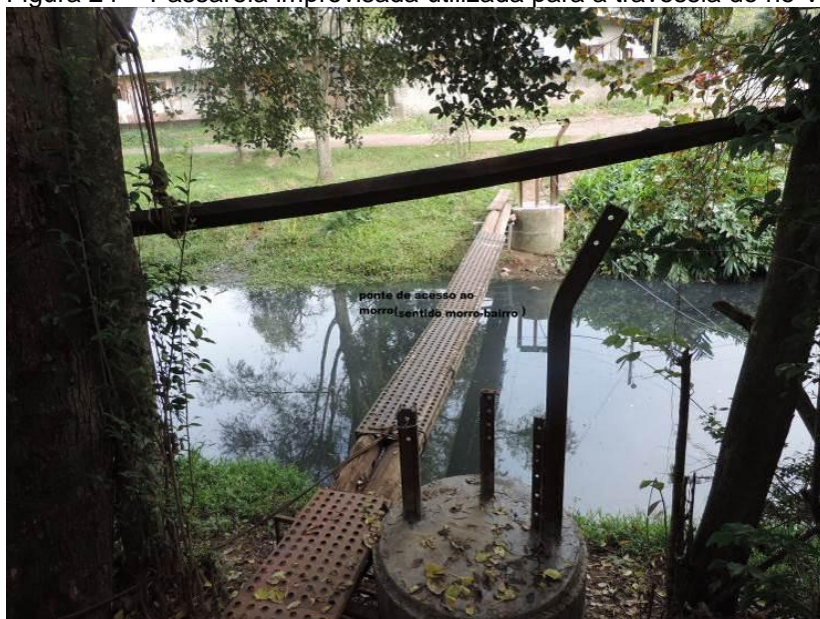
Figura 24 - Passarela improvisada utilizada para a travessia do rio Vacacaí Mirim, no setor 2
