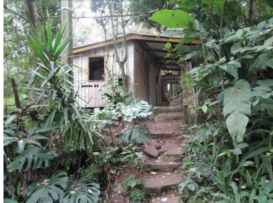
Figura 17 - Fotografia da moradia 23 com risco de deslizamento, em corte realizado em material coluvionar.
