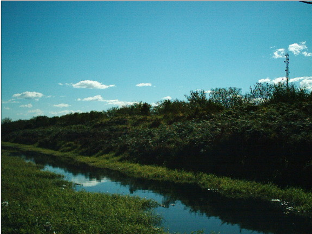
Foto 01: Vista de um dos Pôlderes de Canoas. O Dique do Mathias Velho, localizado no Bairro Mathias Velho tem mais de 8,0 km de extensão e delimita os Bairros Mathias Velho e Harmonia no Município de Canoas – RS. Data: 16/08/03.
