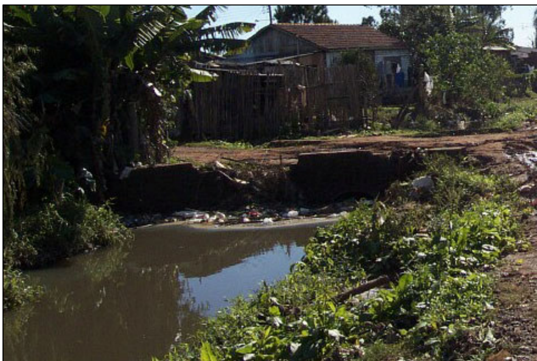
Foto 28: Vala da Vila Eusébio da Rocha no Bairro Guajuviras com água contaminada por esgotos sanitários e lixo. Data: 10/02/2003.
