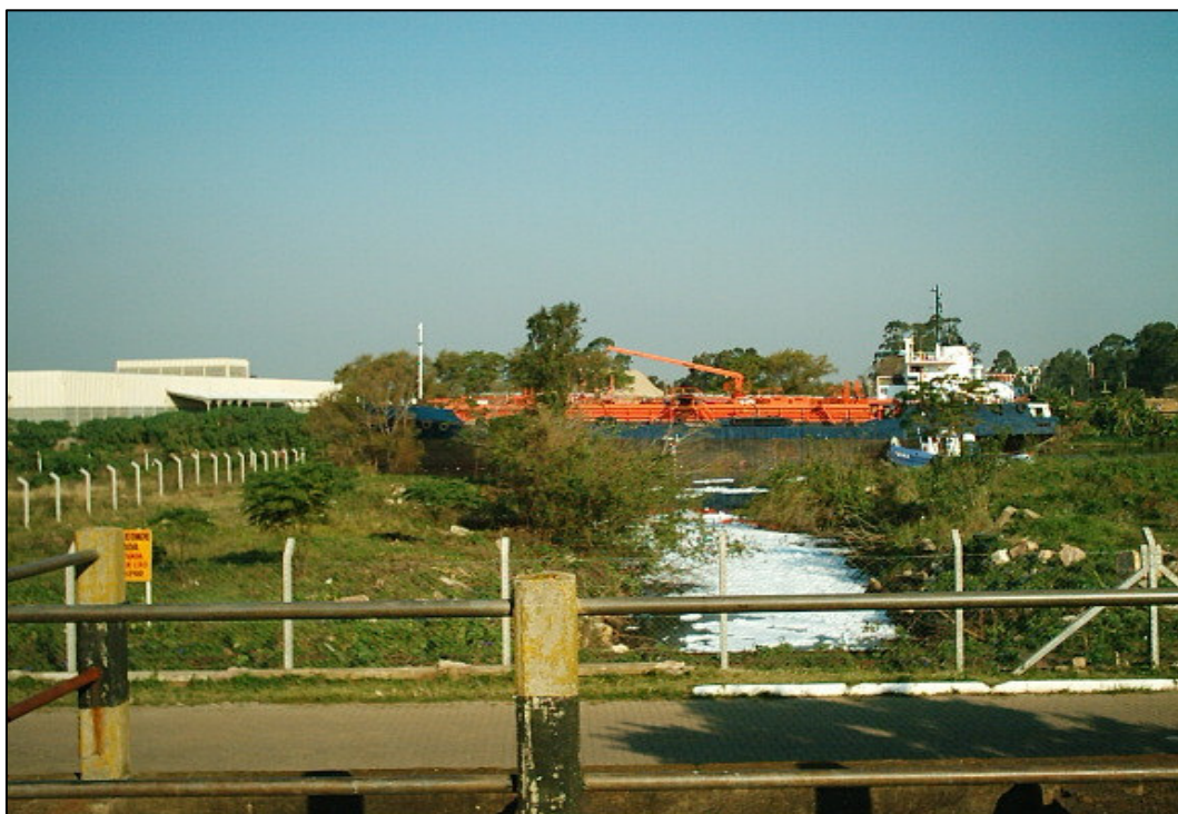
Foto 30: Efluentes sanitários saindo da Casa de Bombas N° 03 em direção ao Rio Gravataí. Data: 21/10/2003.
