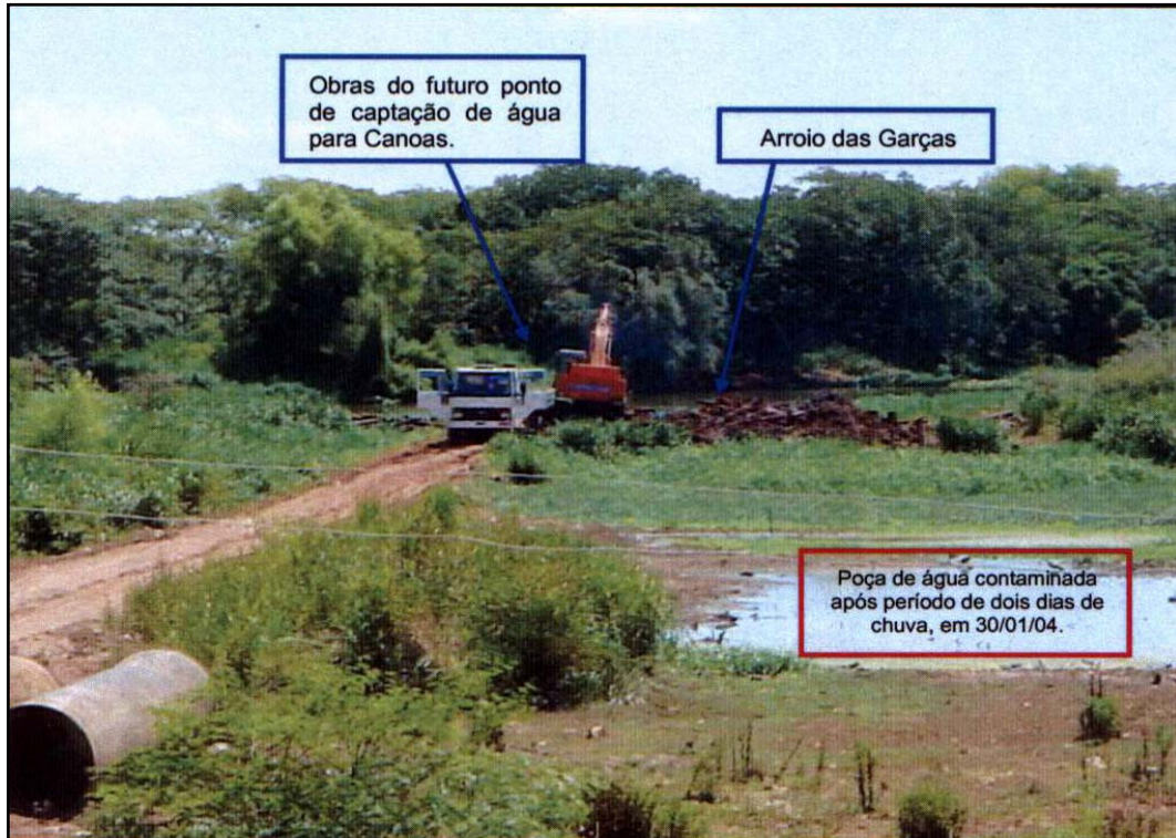
Foto 09: Outro ângulo do local mostrado na Figura 33. Data: 30/01/04.
