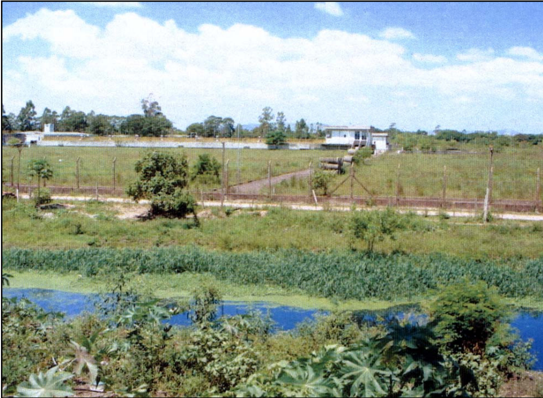
Foto 11: Em primeiro plano escoamento de esgotos “in natura” na vala do Dique do Rio Branco, à margem da cerca que delimita a ETE no Bairro Fátima em Canoas, em segundo plano. Data: 20/02/04.
