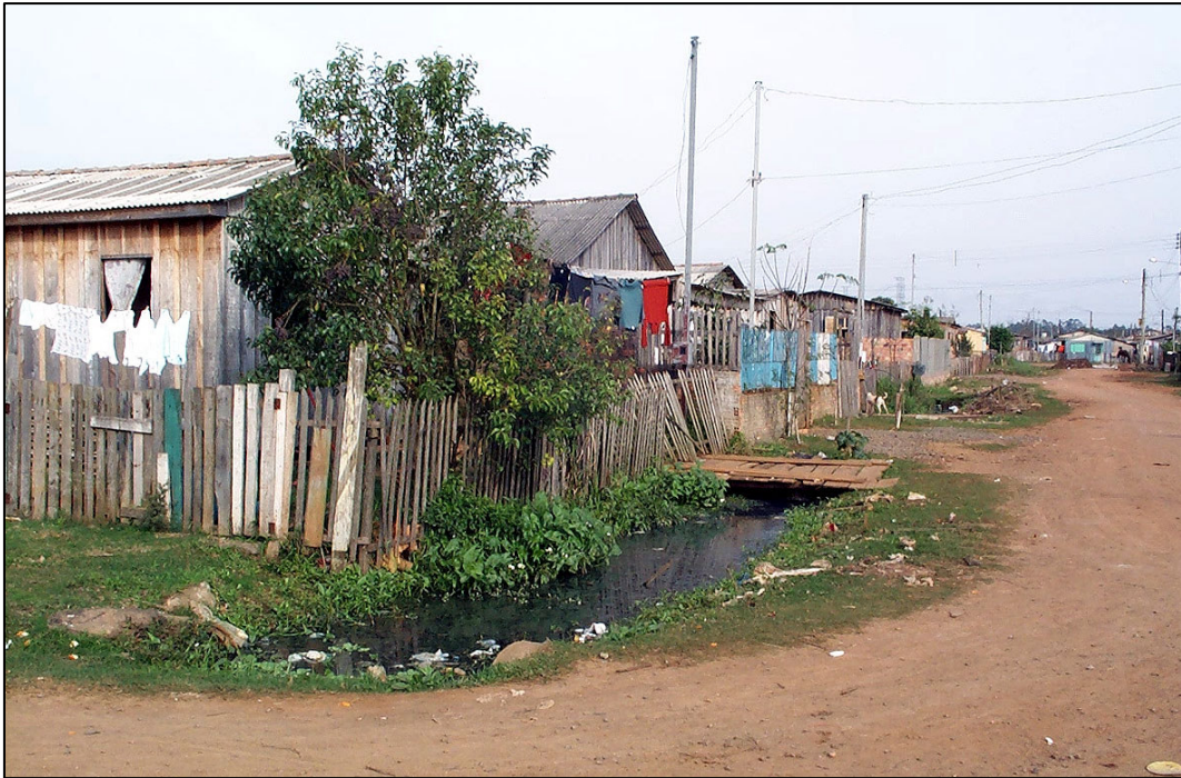
Foto 17: Rua da Vila Getúlio Vargas, no Bairro Mathias Velho com esgoto sanitário escorrendo a céu aberto em frente às moradias. Foto: Prefeitura Municipal de Canoas. Data: 01/07/2003.
