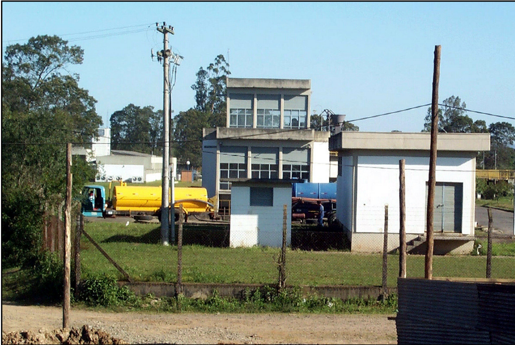
Foto 13: Descarga de esgoto sanitário bruto na ETE observa-se dois caminhões-pipa na câmara de chegada de esgoto bruto. Data 15/10/2003.
