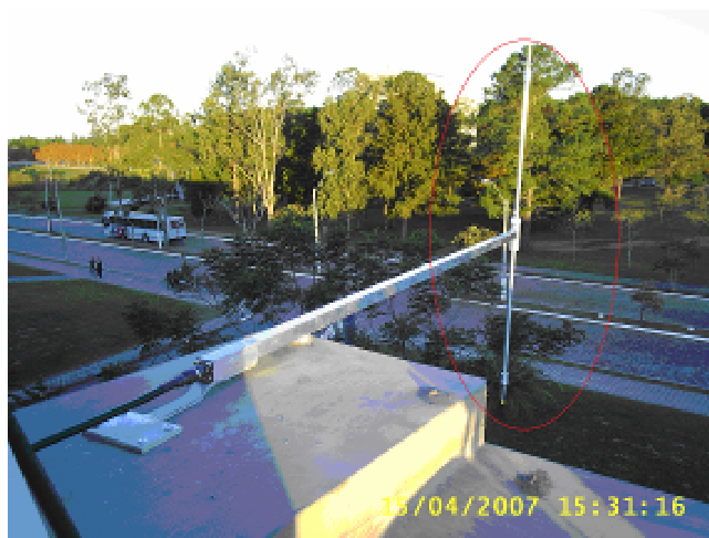
Figura 26 – Antena do transmissor de rádio FM
