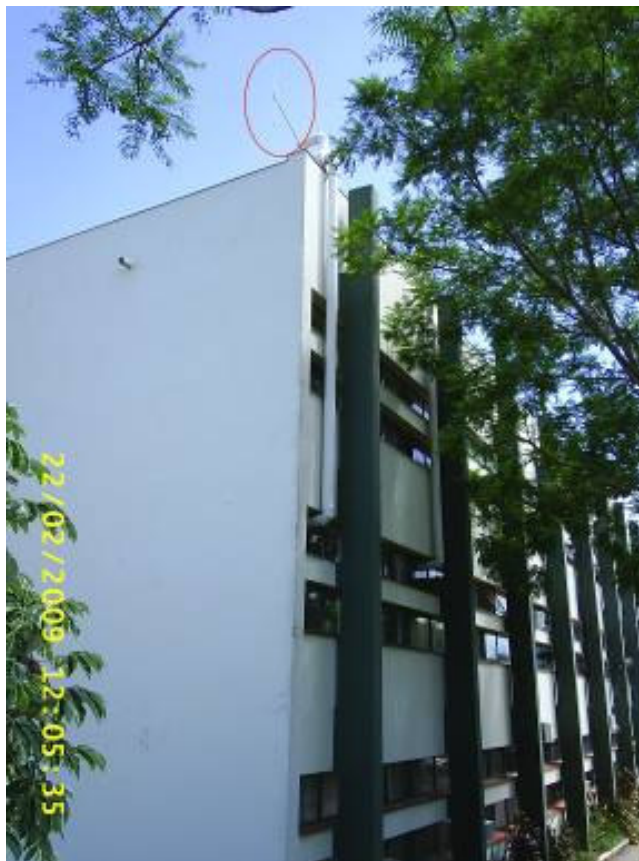
Figura 25 – Antena do transmissor FM no prédio
