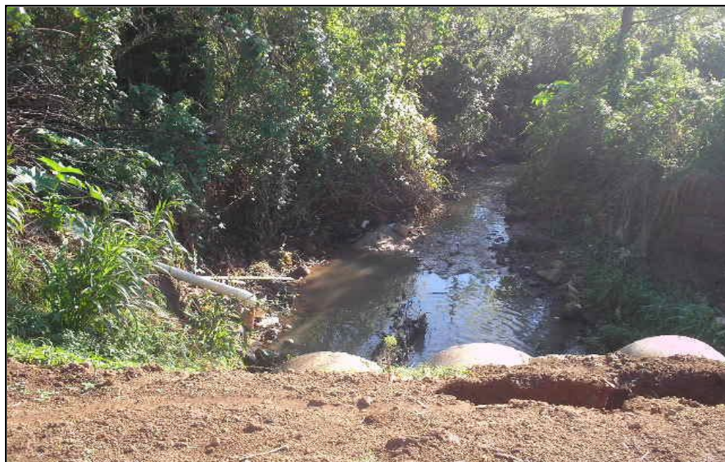
Figura 10: Esgoto clandestino despejado no córrego, no bairro Bonini II Fonte: Trabalho de campo, 19/07/2006.
