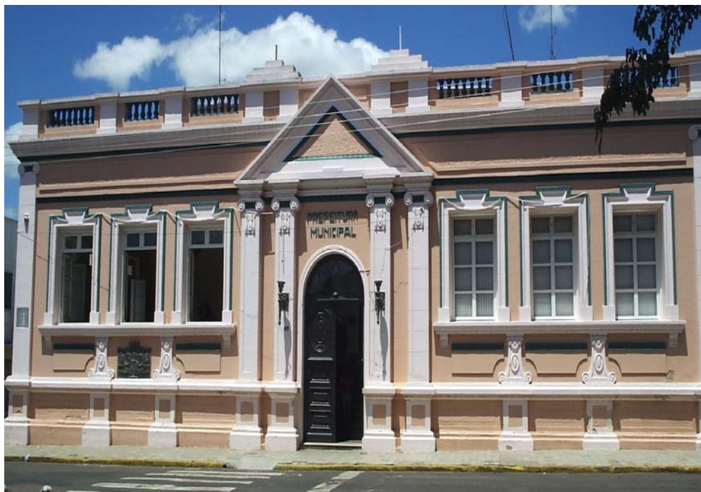
Figura 4 - Vista da Prefeitura municipal de Alegre, construída em 1879.
