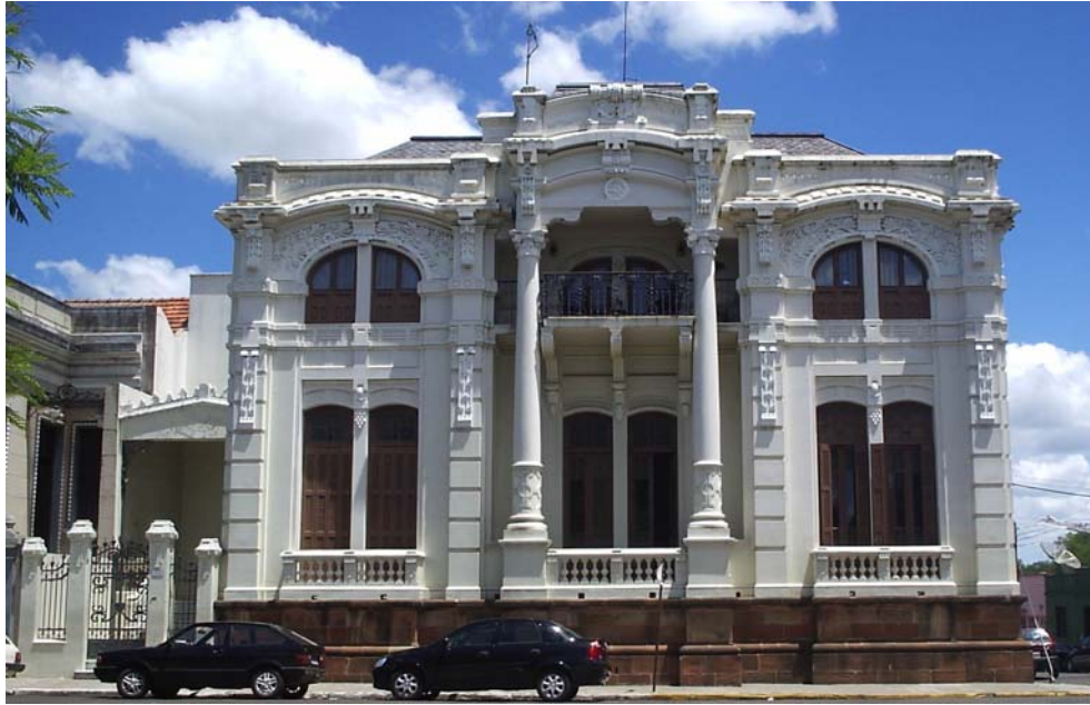
Figura 2 - Vista parcial de residência construída em meados da década de 1920. Fonte: Trabalho de Campo, 2005. Org.: Oliveira Jr. 2005.
