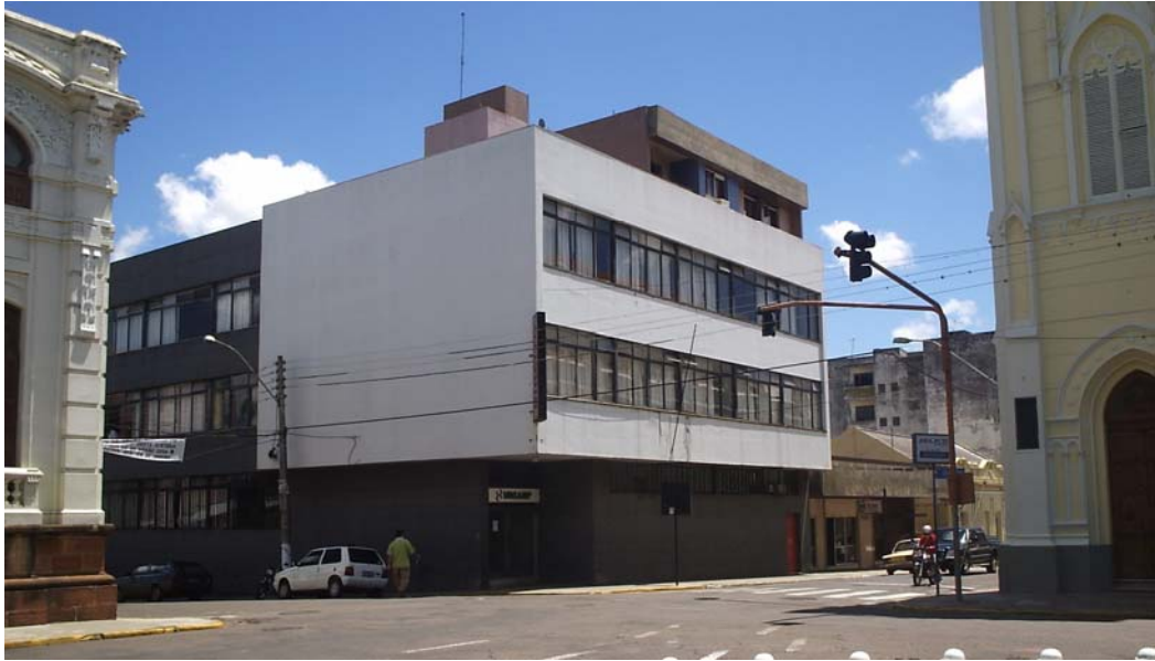
Figura 5 - Vista parcial de construções recentes de Alegrete, prédio do Fórum. Fonte: Trabalho de Campo, 2005. Org Oliveira Jr. 2005.
