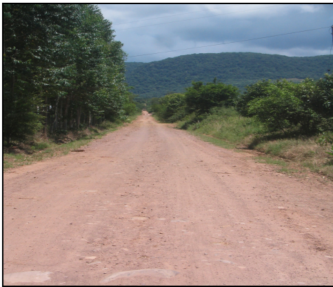
Estrada rural não pavimentada interior do município de Ivorá: Estado de conservação: bom
