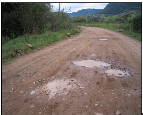
Estrada rural no interior do município de Faxinal do Soturno Passagem de transporte escolar e dos produtos das agroindústrias: Estado de conservação: ruim
