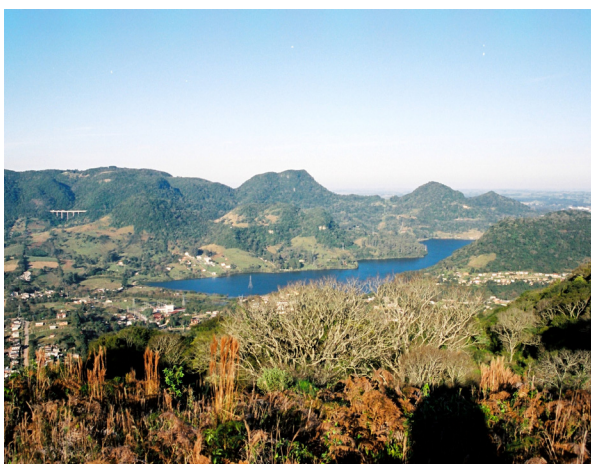
Figura 11 – Vista panorâmica da barragem do DNOS.
