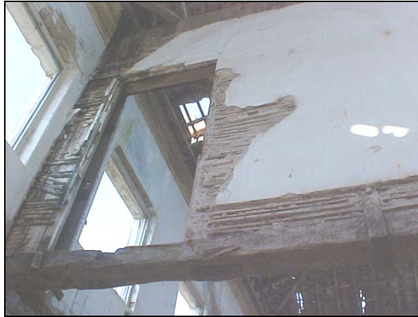
Figura 20 - Foto do 2º piso do Palacete, construída em bambu e coberta de argamassa de cal.
