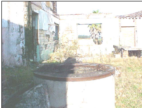
Figura 21: Foto do pátio, nos fundos Palacete, em detalhe o poço.
