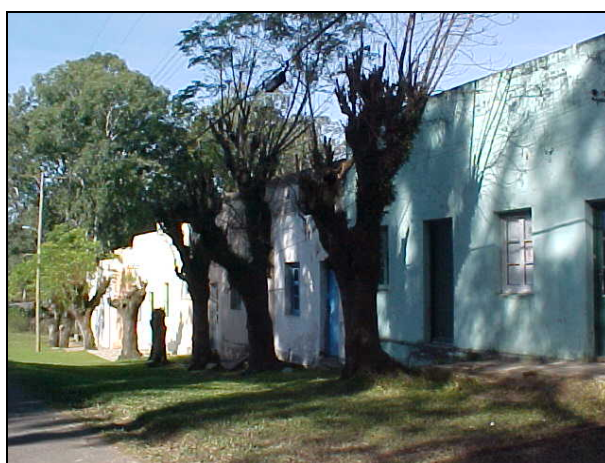
Figura 31 - Foto do conjunto de casas localizados próximos à Indústria de Derivados.
