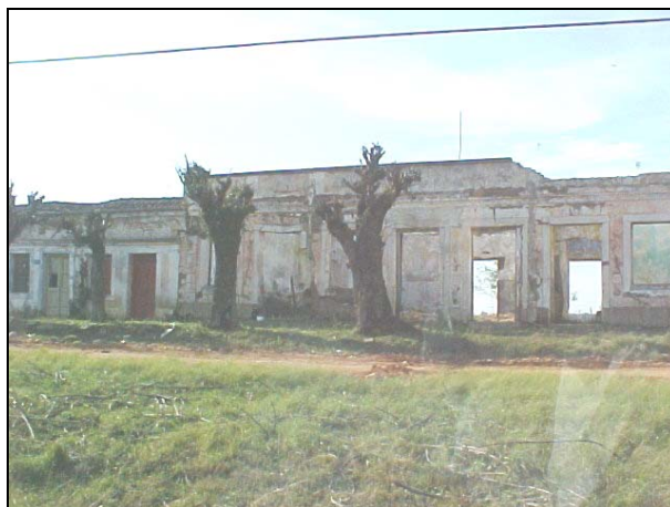
Figura 33 - Foto das reminiscências do Armazém de Silvério de Souza, com data de 2004.
