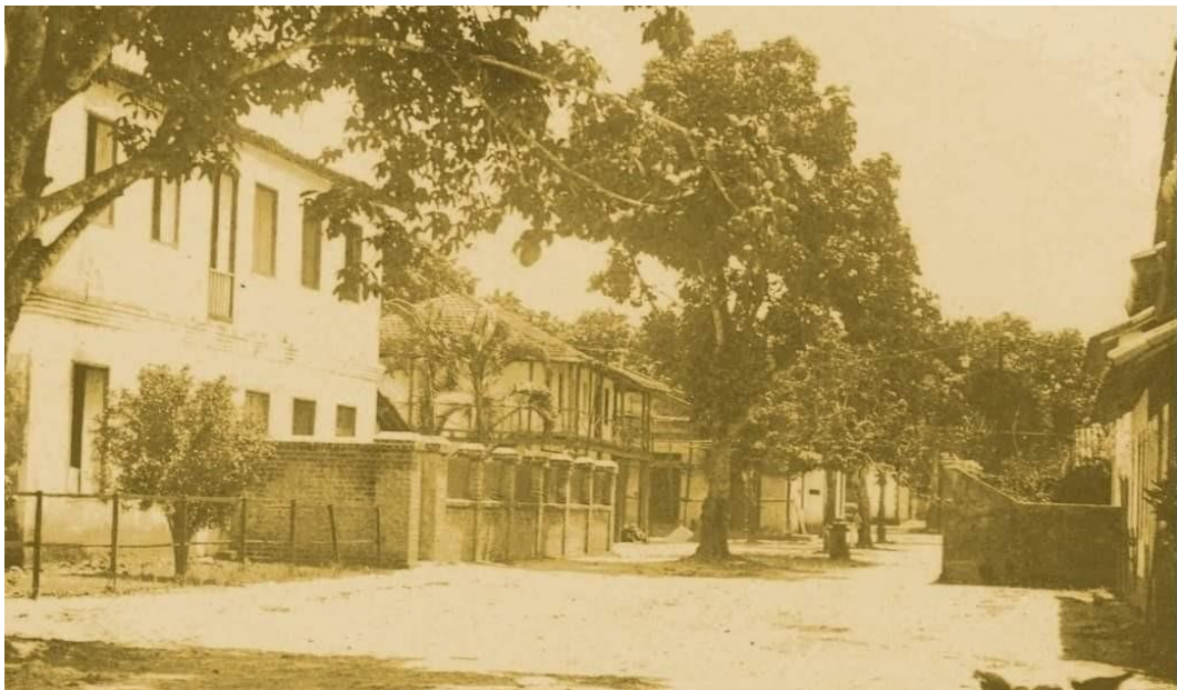
Imagem 4- Parte interna da Vila Operária de Camaragibe.
