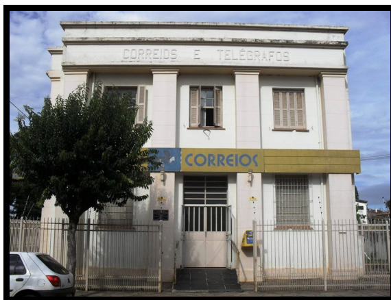
Figura 64 – Fachada Frontal Central de Correios e Telégrafos, 2011. Fonte: O autor, 2011.
