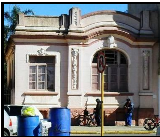
Figura 38 – Fachada Frontal Antiga Residência Hermínio Beck, 2010 Fonte: O autor, 2010.
