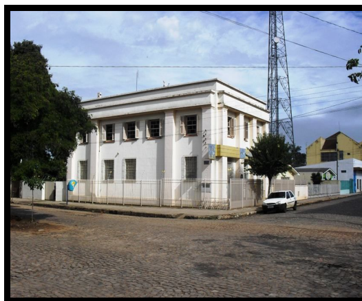
Figura 65 – Perspectiva Central de Correios e Telégrafos, 2011. Fonte: O autor, 2011.
