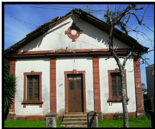
Figura 34 – Fachada Frontal Antiga Residência Edegar Kruehl, 2010 Fonte: O autor, 2010.
