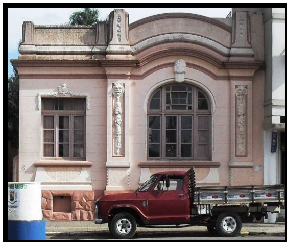
Figura 37 – Fachada Frontal Antiga Residência Hermínio Beck, 2010 Fonte: O autor, 2008.
