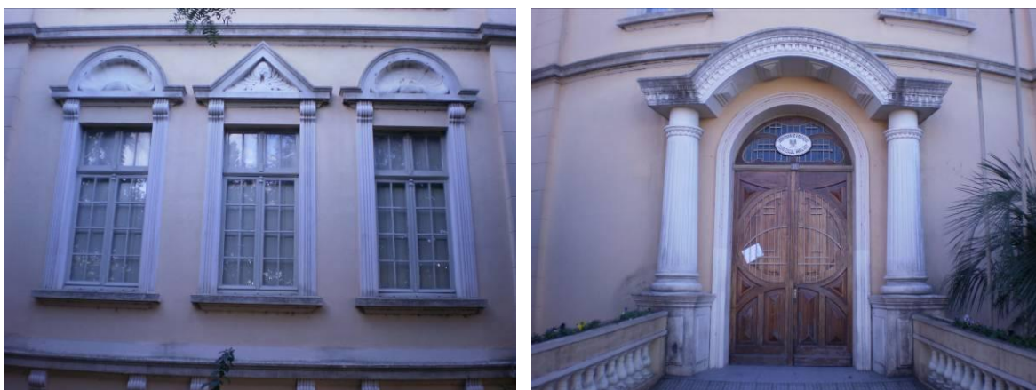
Figura 34 – Janelas, pórtico e porta principal do Colégio Estadual Manoel Ribas Fonte: Pedro Morales
