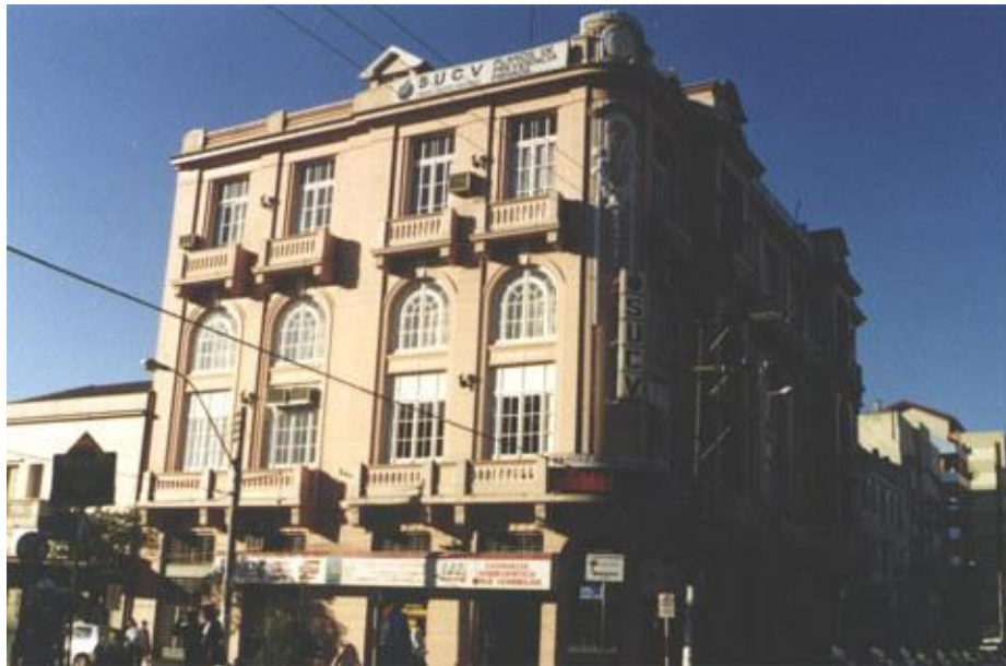
Figura 5 – Prédio da SUCV - Sociedade União dos Caixeiros Viajantes Fonte: http://2.bp.blogspot.com/
