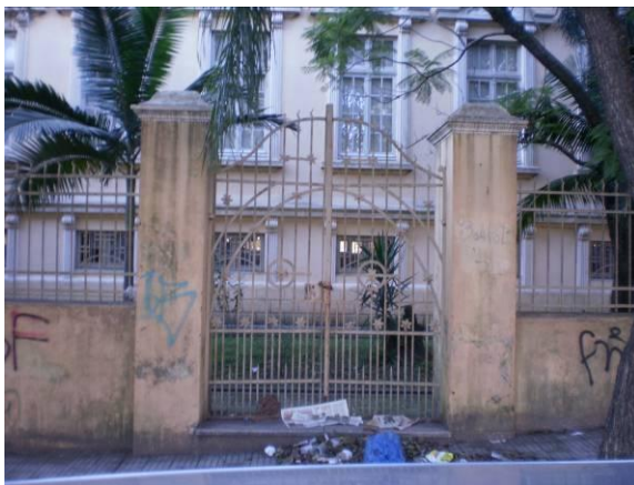
Figura 35 – Portão lateral do Colégio Estadual Manoel Ribas Fonte: Pedro Morales
