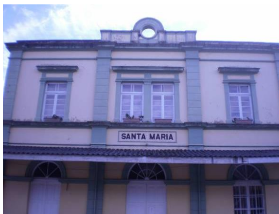
Figura 23 – Frontão e janelas da Estação Férrea de Santa Maria Fonte: Pedro Morales
