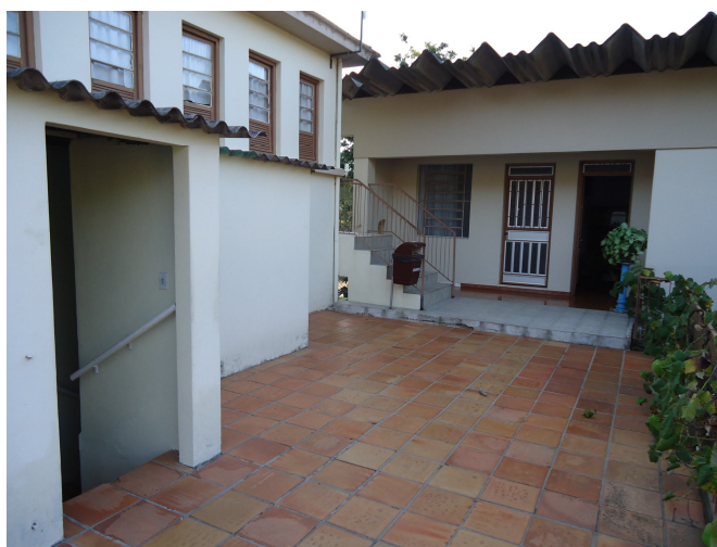
Figura 7 – Vista da escada de acesso e da porta de entrada do CPG. Fonte: acervo pessoal da autora.
