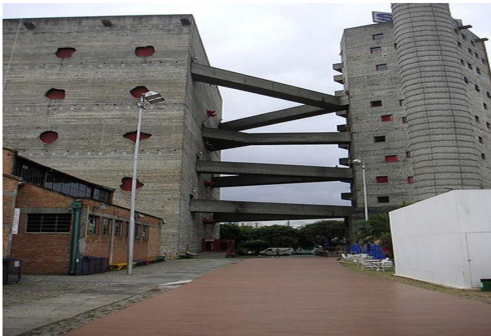
Foto 2.1 – SESC Vila Pompéia, antiga fábrica revitalizada pelo projeto de Lina Bo Bardi. Fonte: Wikipédia.
