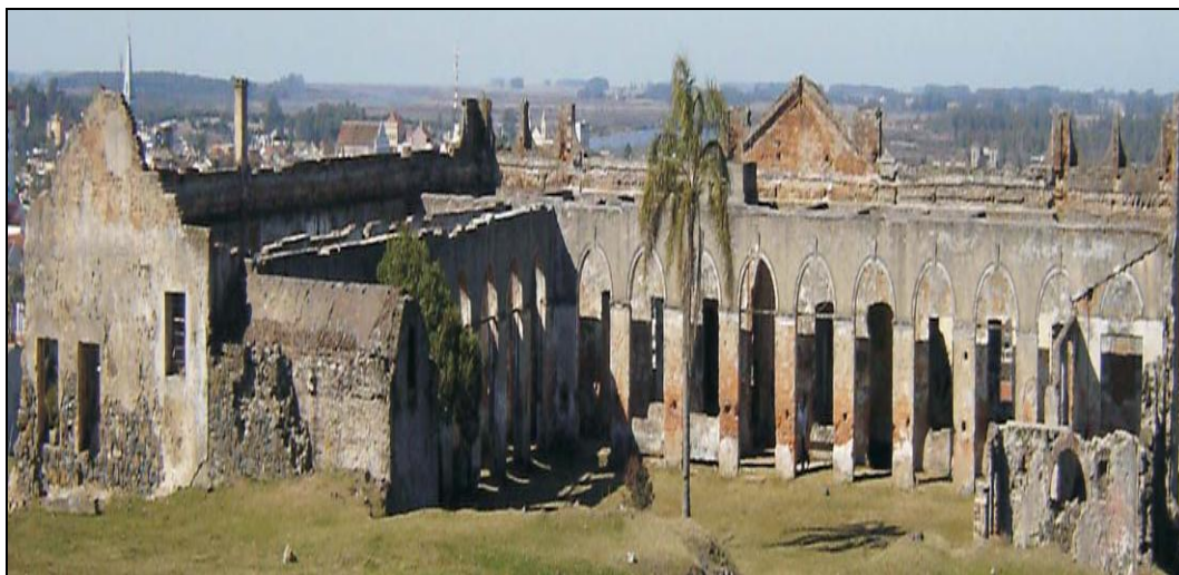
Foto 1.9 – Vista noroeste das ruínas, ao lado esquerdo, o antigo necrotério, ao centro, o pátio interno circundado pelas portas em arcos.
