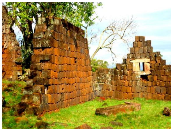
Imagem 16 – Paredes que ainda estão de pé em São Lourenço.
