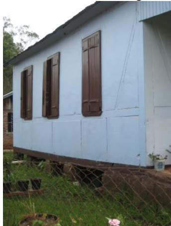
Fachada lateral esquerda
