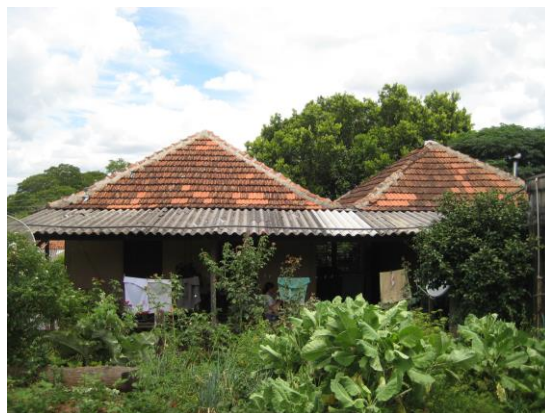
Cobertura da residência
