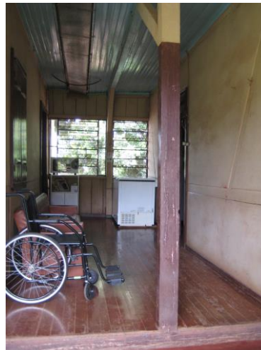
Varanda que interliga o corpo principal da casa e a cozinha
