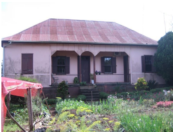
Figura 28: Cobertura da residência com quatro águas e telhas metálicas – Residência Sander.
