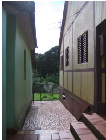
Fachada lateral esquerda
