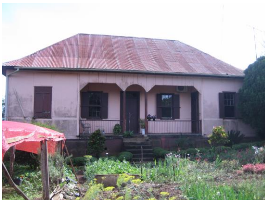
Fachada Frontal residência Sander
