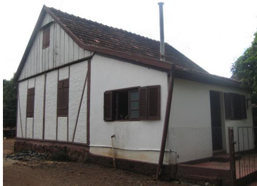
Fachada Frontal residência Kreutz I
