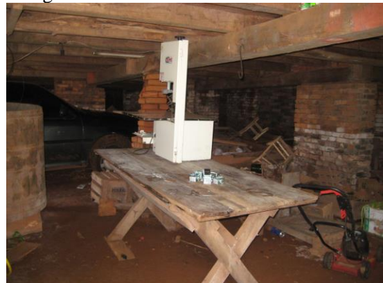
Vista interna do porão
