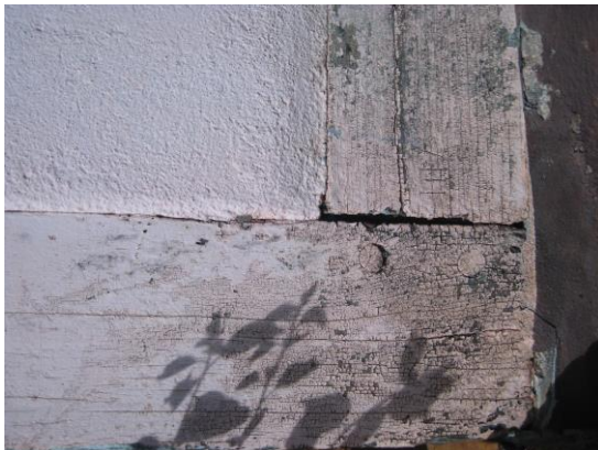
Esteio de canto encaixado no baldrame
