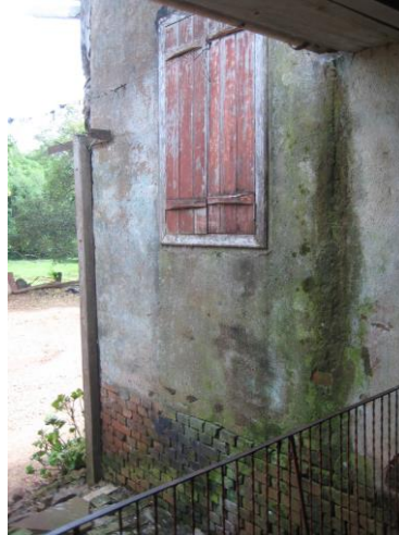
Fechamento do porão com tijolos
