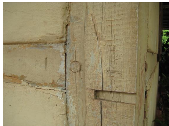
Detalhe da fixação da estrutura de madeira
