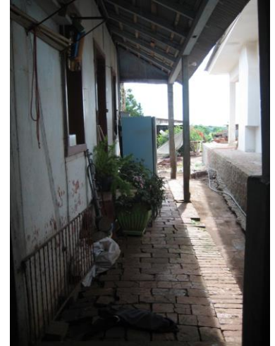
Piso de tijolos na varanda
