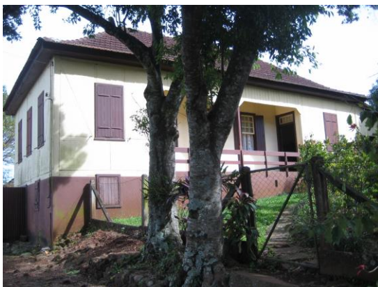
Fachada Frontal residência Assmann
