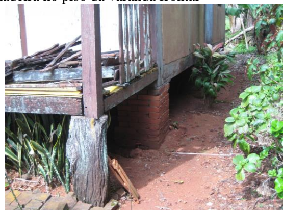
Fundação de madeira e tijolos na sustentação
