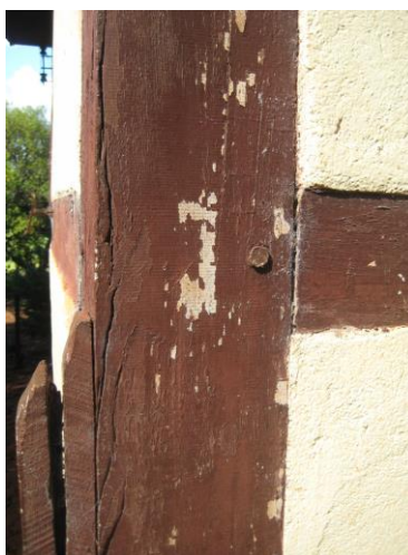
Detalhes da fixação da estrutura de madeira
