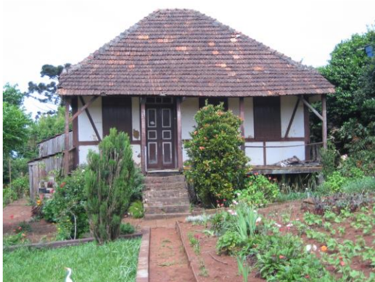
Fachada Frontal residência Schommer
