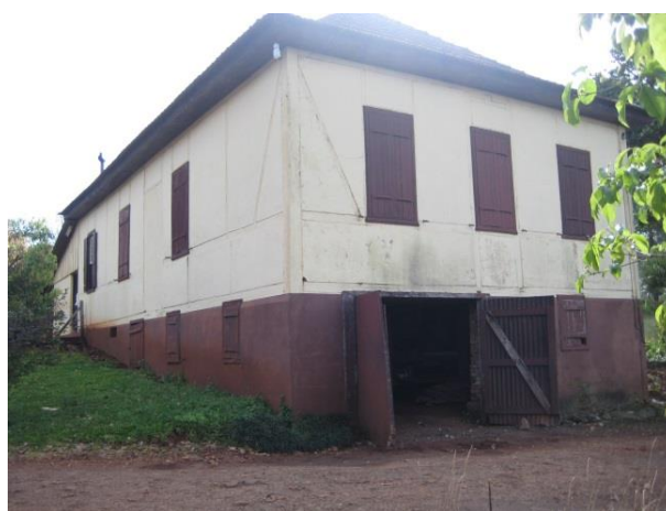
Figura 24: Fundação de alvenaria de tijolos maciços e porão semi enterrado – Residência Assmann. Fonte: A autora, 2014.
