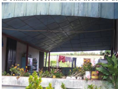
Forro varanda dos fundos
