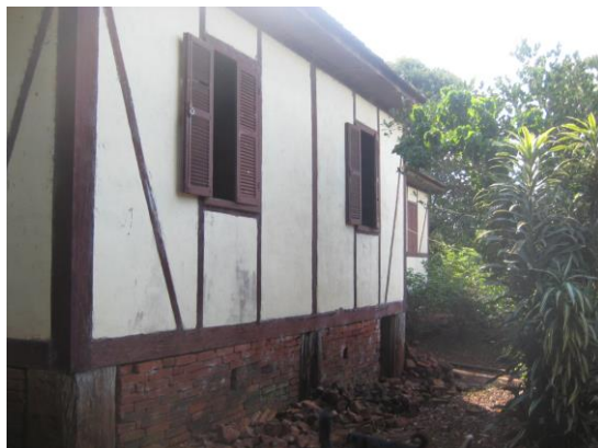
Pilares de madeira e tijolos maciços na sustentação do baldrame
