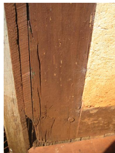
Detalhes da fixação da estrutura de madeira
