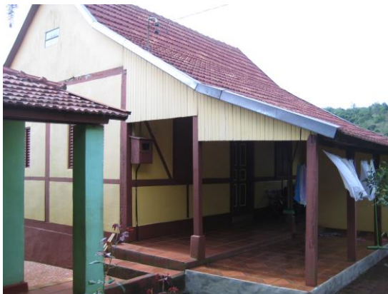
Fachada Frontal residência Ghiel
