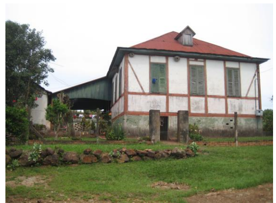
Fachada Lateral residência Freisleben
