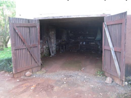
Vista interna no porão/garagem
