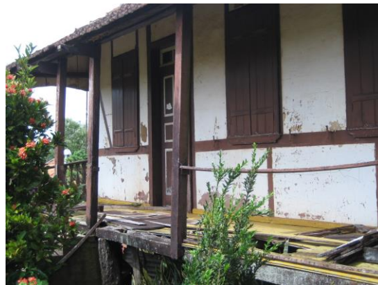
Assoalho de madeira no piso da varanda frontal
