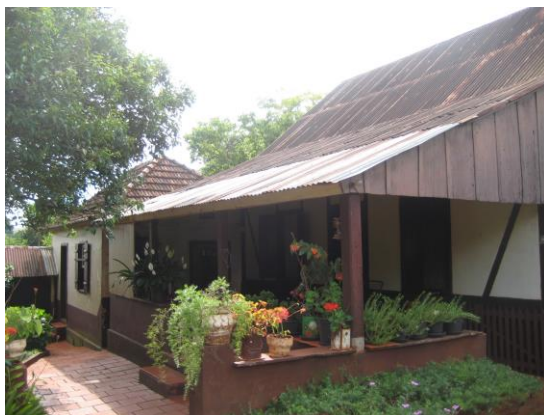
Cozinha anexa ao corpo principal da residência
