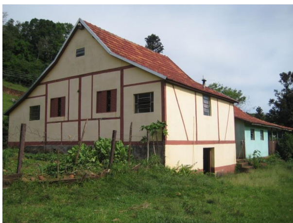
Figura 29: Cobertura da residência com duas águas e telhas cerâmicas francesas – Residência Ghel.
