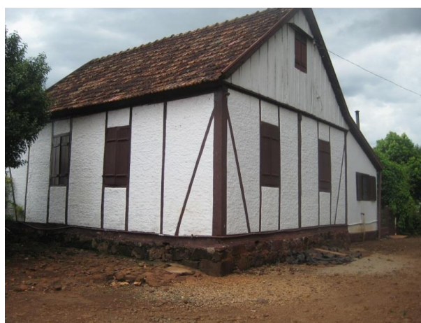
Figura 22: Fundação de pedra - Residência Kreutz I.
