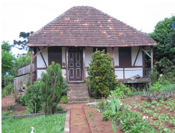
Figura 25: Peças de madeira aparentes e pintadas com cor mais escura – Residência Schommer. Fonte: A autora, 2014.
