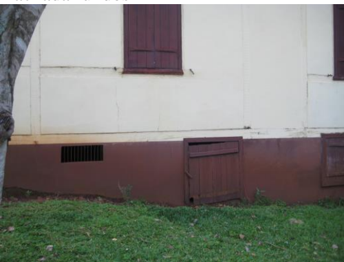
Aberturas na fachada para ventilação do porão
