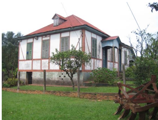
Fachada Frontal residência Freisleben
