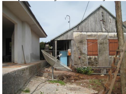
Proximidade entre as duas edificações
