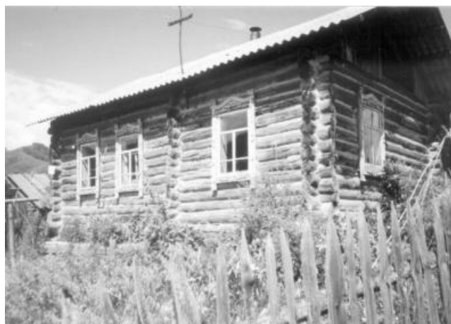
Figura 03: Construção em blocausse. Fonte: Gislo, 2013, p. 44.
