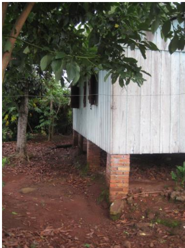
Pilares de tijolos maciços no fundamento
