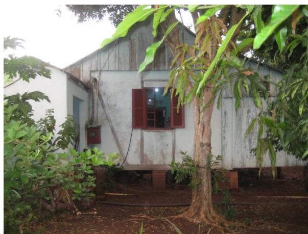
Figura 27: Paredes externas da edificação em madeira— Residência Jung.
