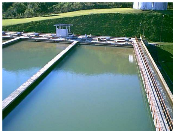
FIGURA 4 – Fotografia do Decantador da ETA de Santa Maria - RS
