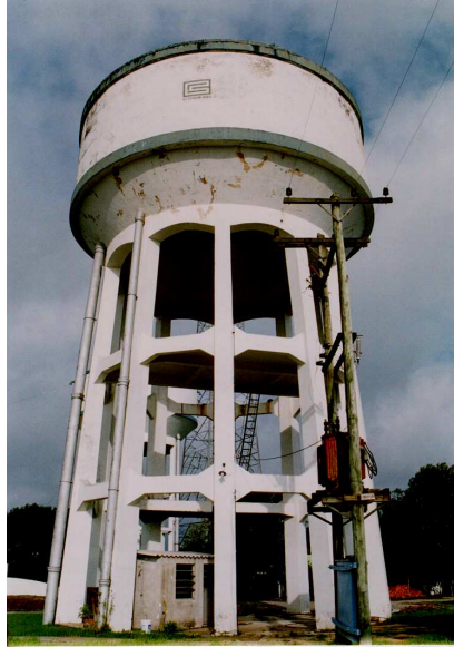
FIGURA 7 – Reservatório Elevado de 500 m 3 de Santiago-RS
