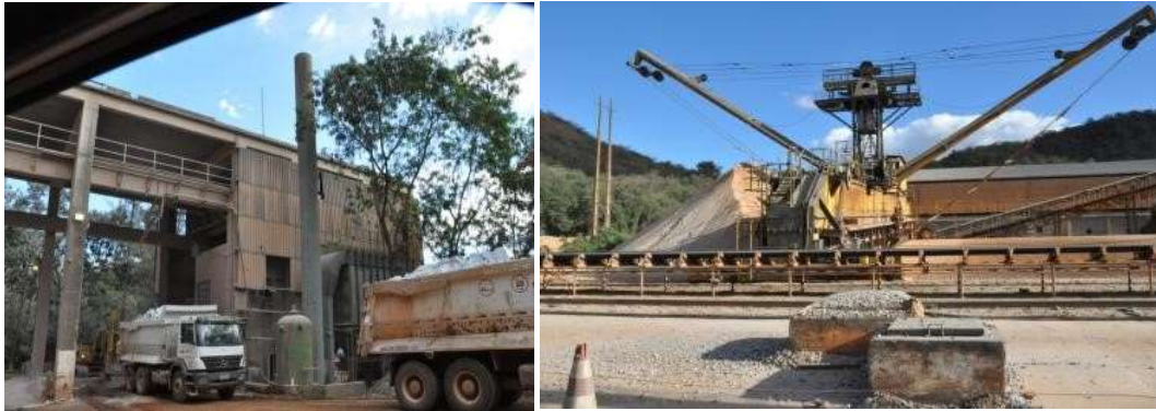
Figura 4 – Estação de britagem e Baía de Pré Homogeneização e Dosagem
