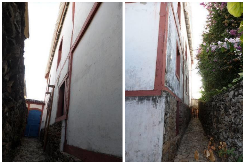
Figura 4 – Fachadas lateral direita e esquerda
