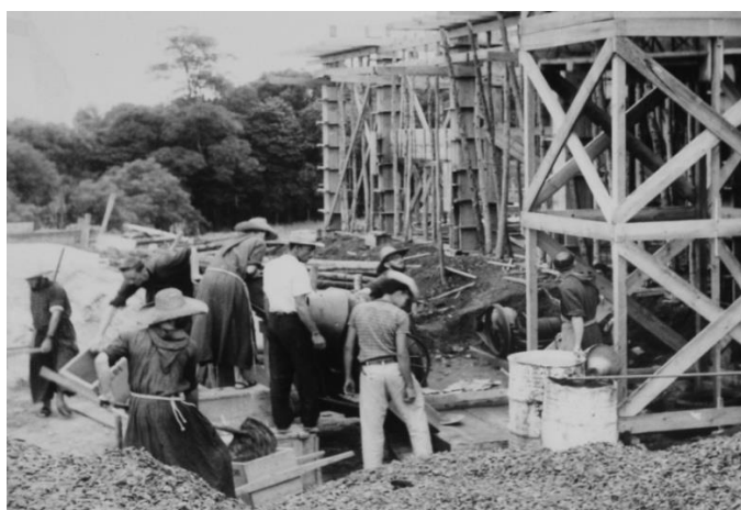
Fotografia 19 – Construção da Sede Acadêmica da FAFI - 1964 Fonte: Acervo do MADP
