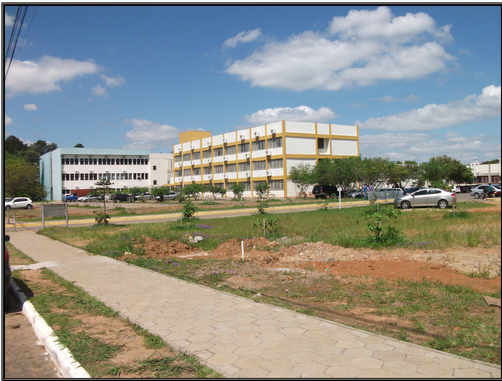
Construção ampliação do Centro de Educação – CE
