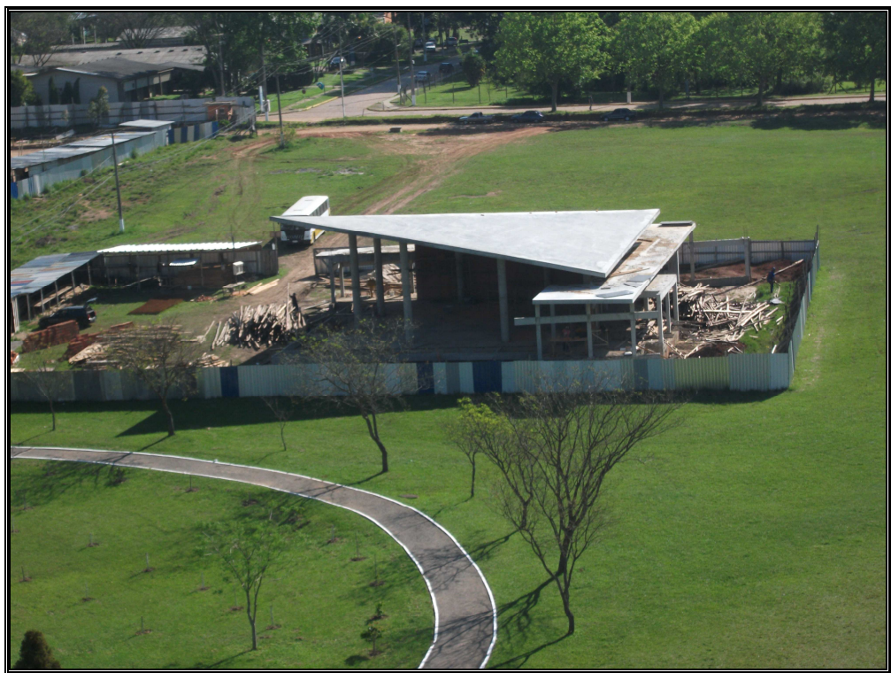
Construção do Centro Ecumênico – vista do 8º andar da Reitoria- em execução
