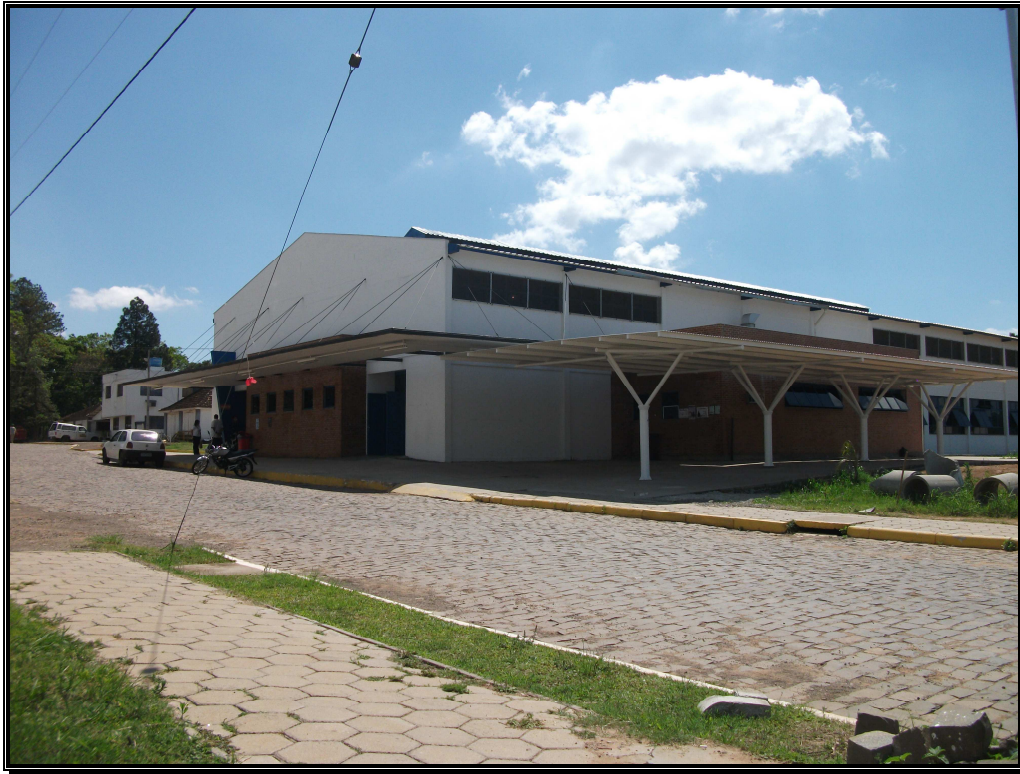
Construção Prédio do Restaurante Universitário-RU (fundos do CT)
