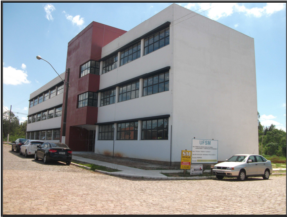
Construção da Unidade básica de ensino, laboratórios e pavilhão de máquinas 1 - CTISM
