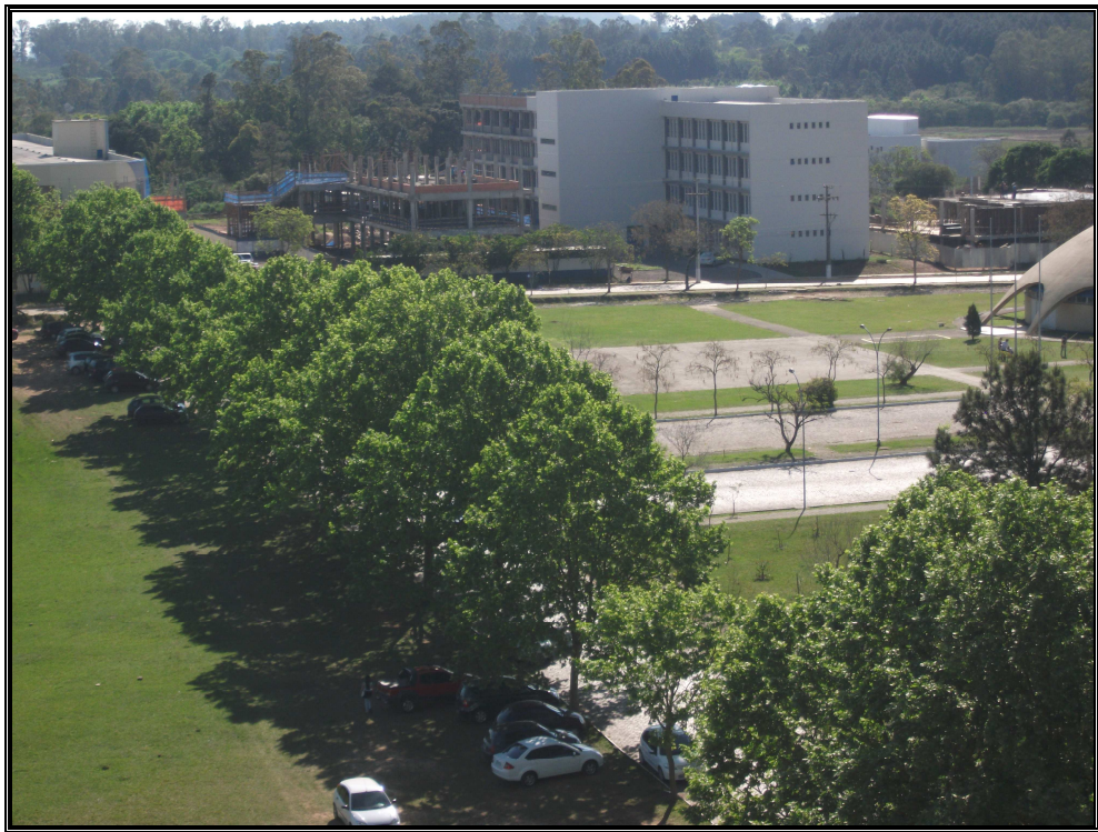
Construção dos prédios: Bloco 74, bloco B1, Bloco C2, Biblioteca de Humanidades do CCSH ao fundo – vista do 8º andar da Reitoria
