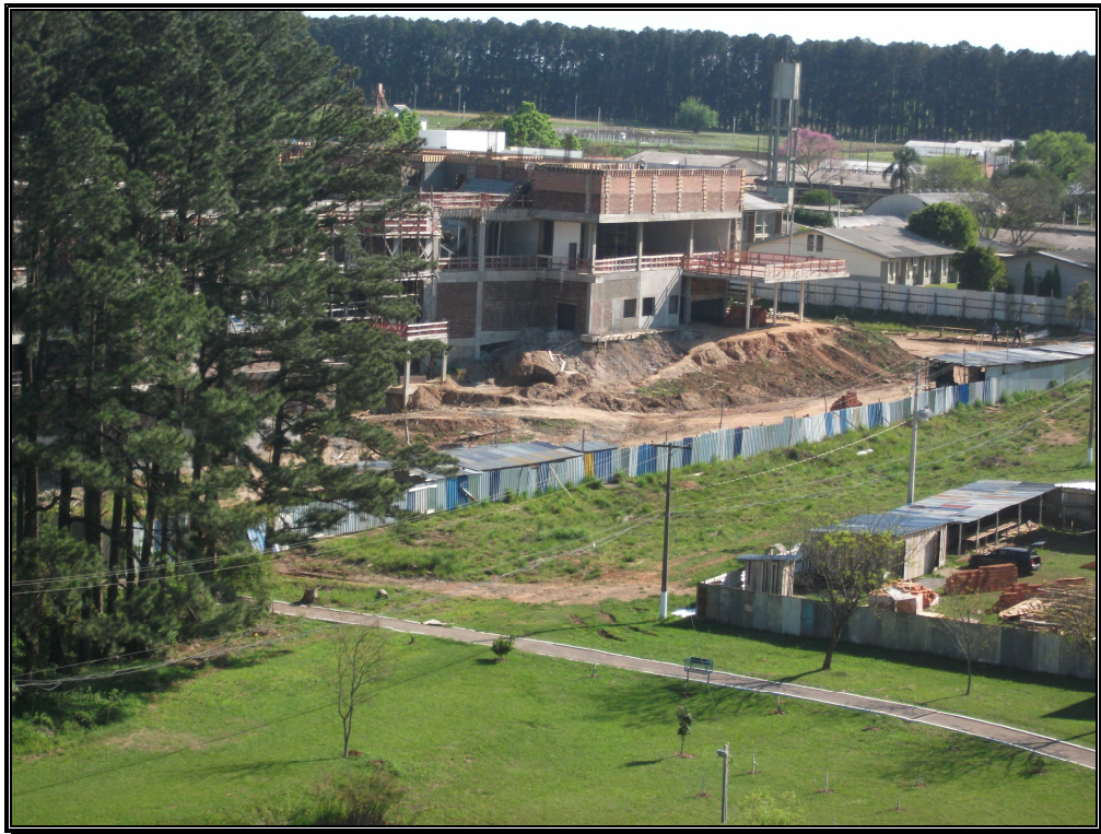
Construção do Centro de Convenções – vista do 8º andar da Reitoria – em execução
