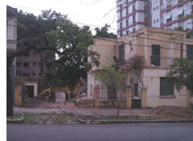
Figura 25 – Residência na Rua Marquês do Pombal Demolição de mais um prédio.
