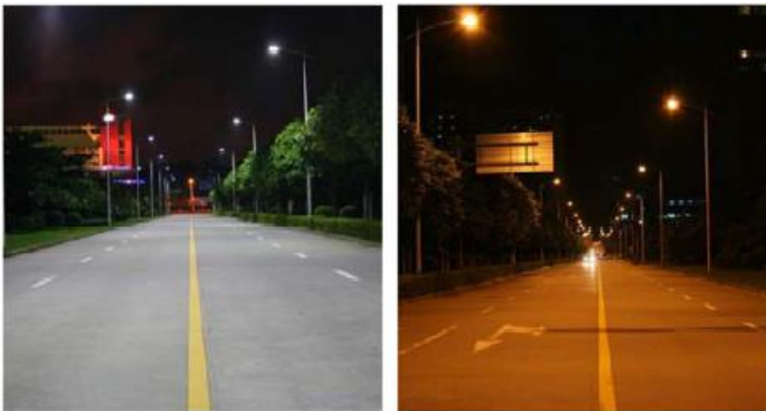
Figura 3 - Visão mesópica: comparação entre luminárias LED e VSAP.
