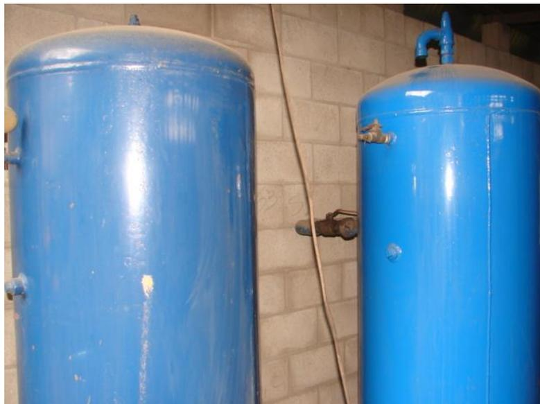
Figura 3: Reservatórios de ar comprimido.
