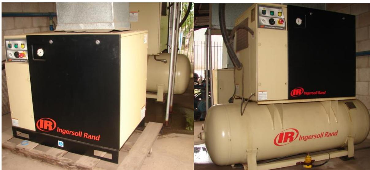
Figura 2: Compressores de ar do tipo parafuso da marca Ingersoll-Rand.
