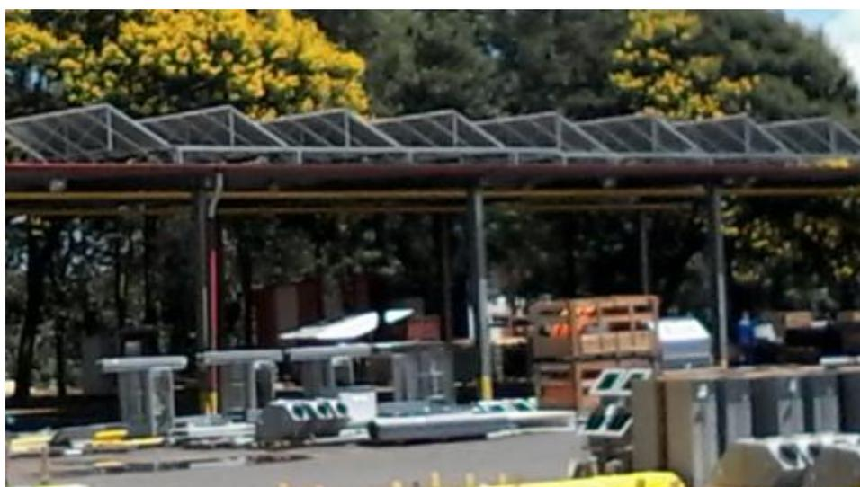
Figura 04 – Coletores solares do sistema de aquecimento de água. Fonte: arquivo pessoal.
