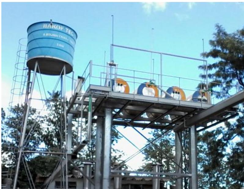
Figura 03 – Sistema de aquecimento de água instalado. Fonte: arquivo pessoal.
