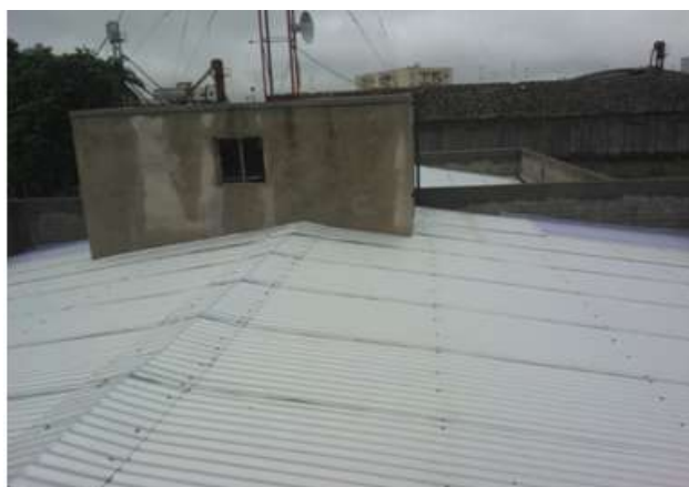
Figura 3 – Telhado em duas águas da edificação.
