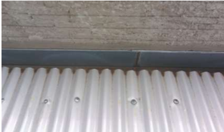
Figura 4 – Sistema de calhas da edificação.
