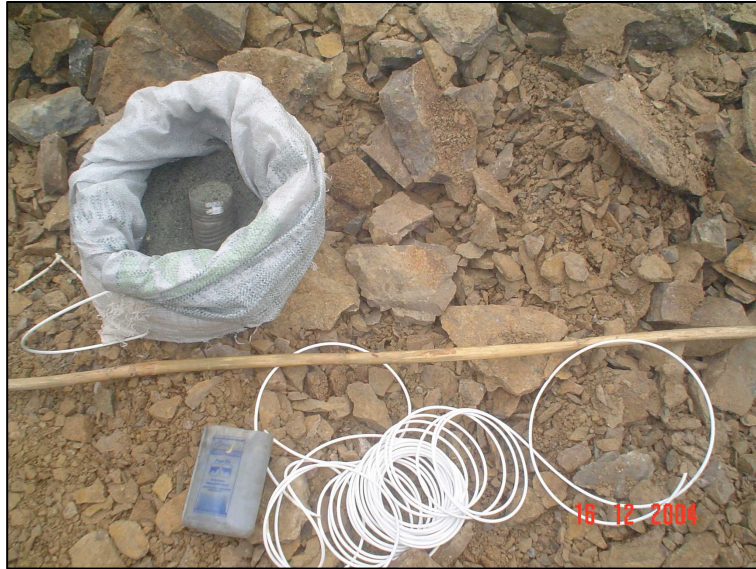
Figura 4.3 – Detalhe dos explosivos e acessórios utilizados no desmonte de rocha
