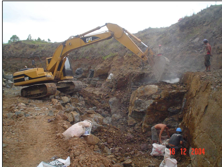
Figura 4.1 – Processo mecanizado de escavação
