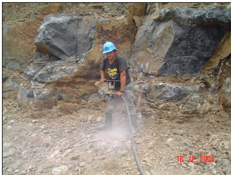
Figura 4.2 – Abertura de furos na rocha com perfuratriz manual
