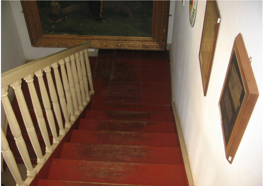
Ilustração 4 – Parte das escadas do Arquivo Histórico de Cruz Alta possui corrimão em apenas um dos lados.
