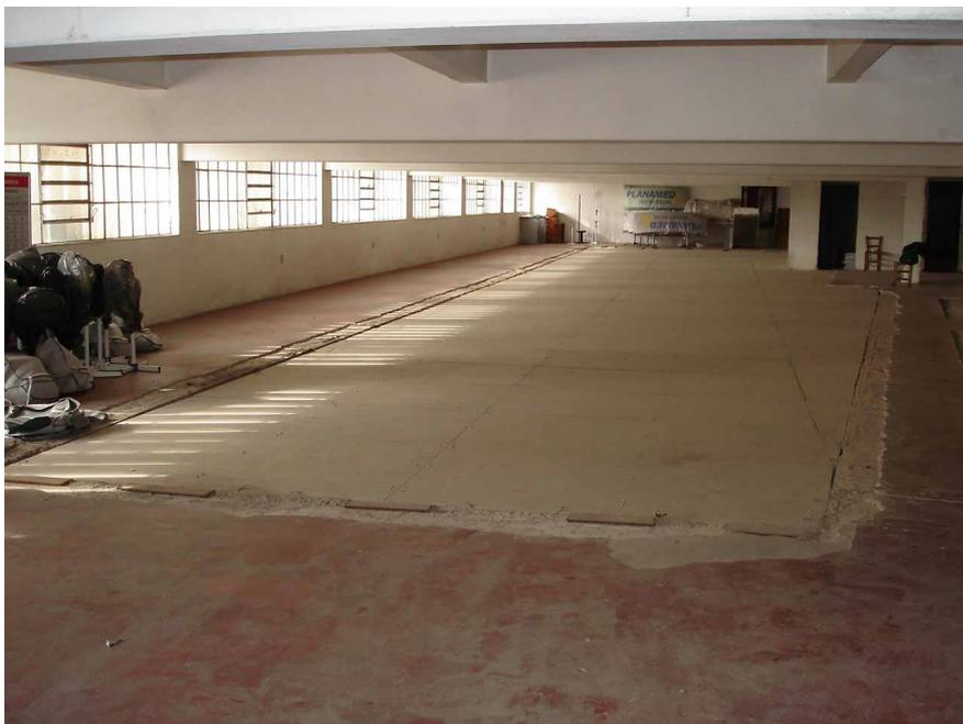
**Figura 122:** Piso comprometido pela falta de manutenção. Vão do mezanino fechado.
