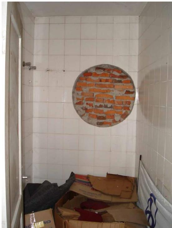
**Figura 93: Janela dos banheiros fechadas com tijolo cerâmico.**
