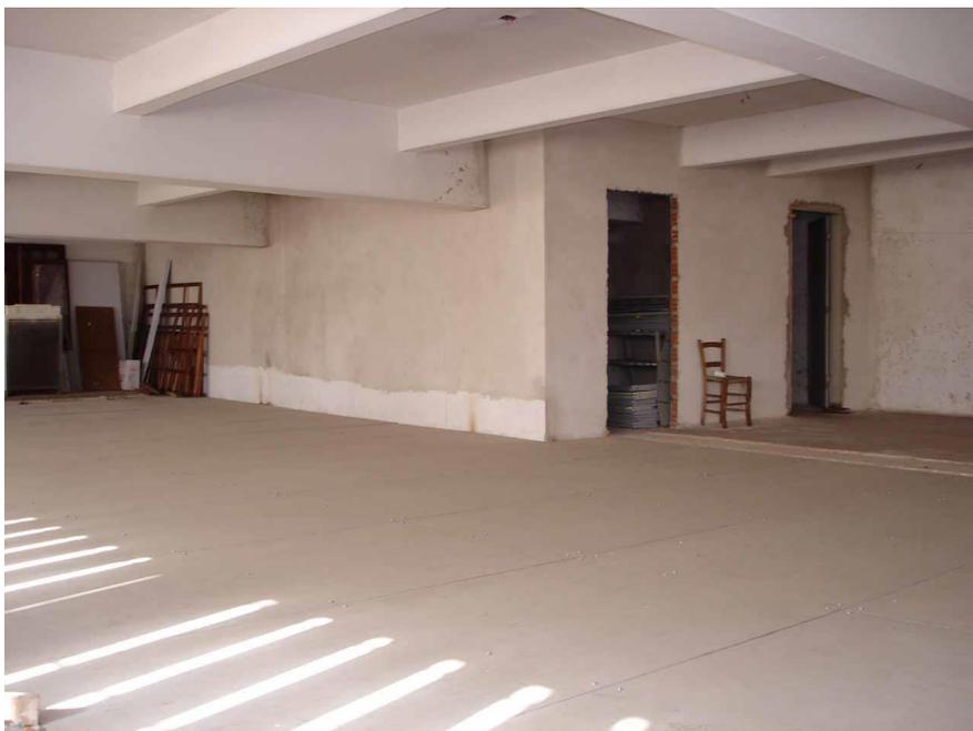
**Figura 123:** Portas sem caixonetes e alisares e pintura comprometida.
