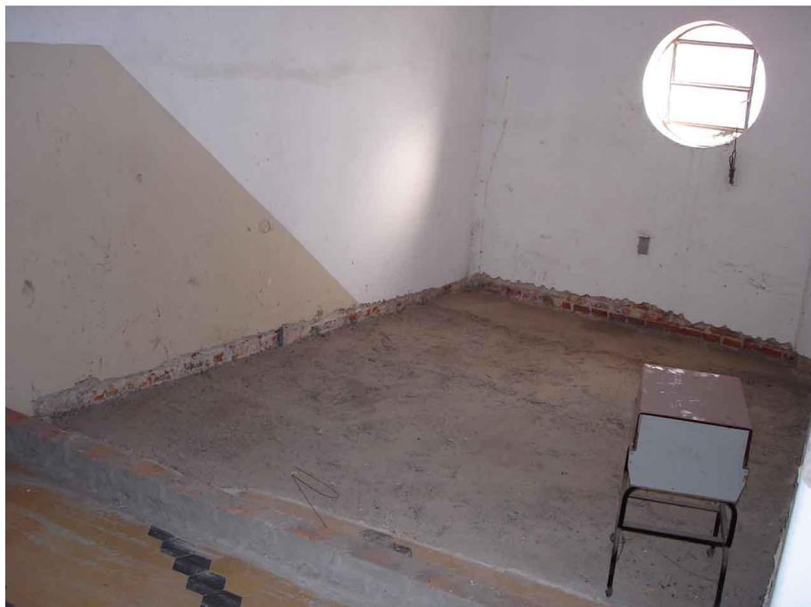
**Figura 65:** Vão da escada que foi demolida com laje concretada.
