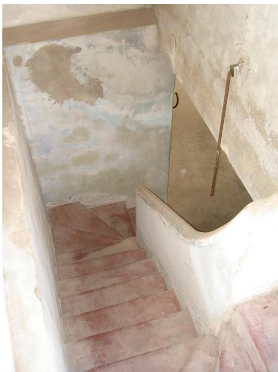
**Figura 115:** Piso em cimento queimado comprometido pela falta de manutenção,
