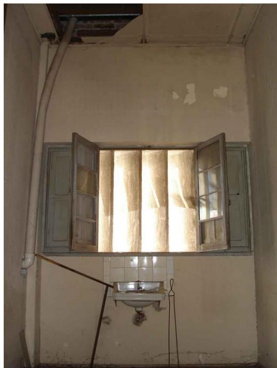
**Figura 121:** Janela com vidros quebrados e sem pintura devido a falta de manutenção.
