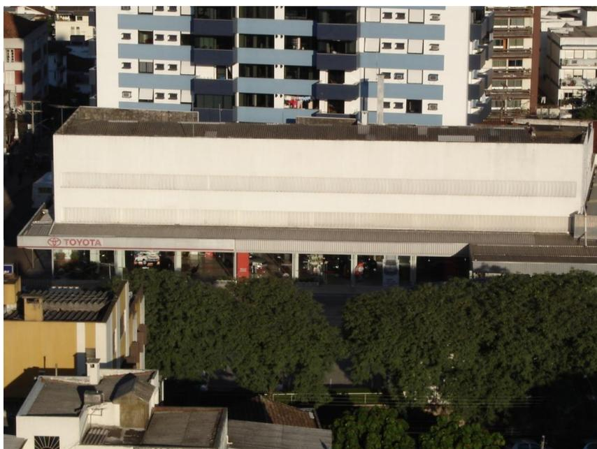
**Figura 107:** Telhado escondido composto por 2 águas em fibrocimento, coroamento com platibanda maciça em alvenaria de tijolo de barro cozido assentados com argamassa de cal e areia.
