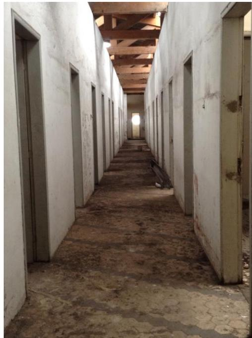
**Figura 109:** Lajota do piso comprometida, assim como as paredes, os caixonetes e alisares das portas (manchas causadas pelos dejetos dos morcegos).
