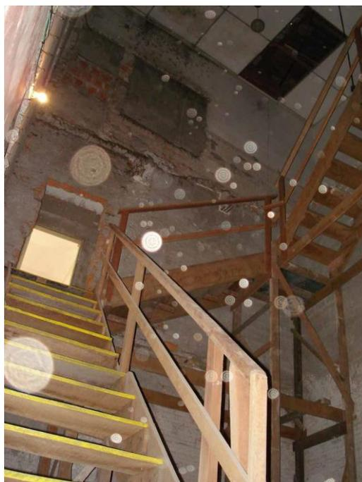
**Figura 44:** Escada de madeira improvisada que fizeram para acessar os pavimentos superiores. Para coloca-la, foi necessário fazer um rasgo na laje.
