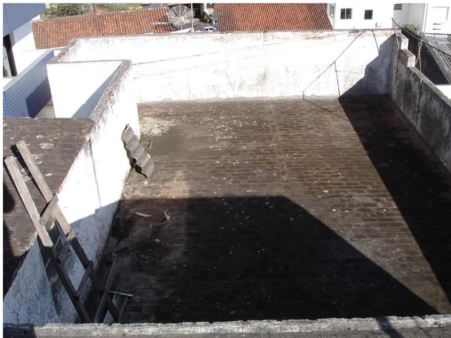
**Figura 114:** Piso do terraço comprometido pela falta de manutenção
