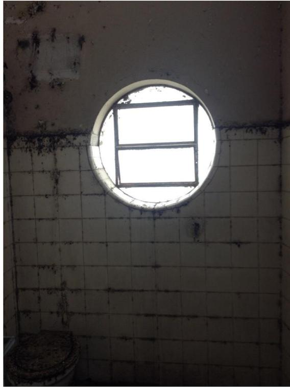
**Figura 112:** Paredes com umidade e dejetos de morcego.
