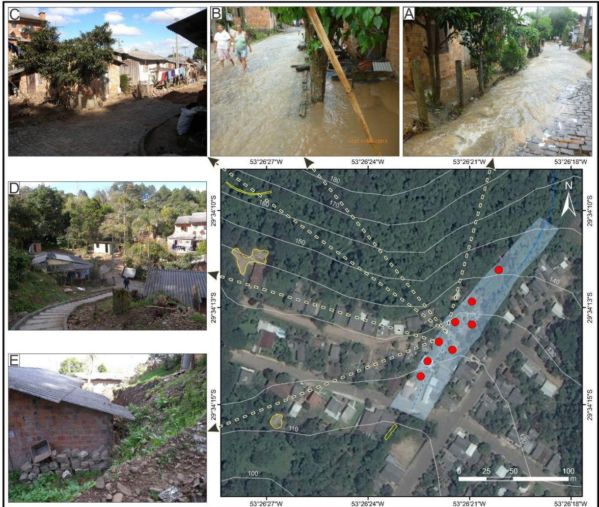
Figura 37 - Situação (IV) de perigo muito alto em setor de reincidência de enxurradas e intervenções antrópicas de corte e aterro (A, B, C, D e E).
