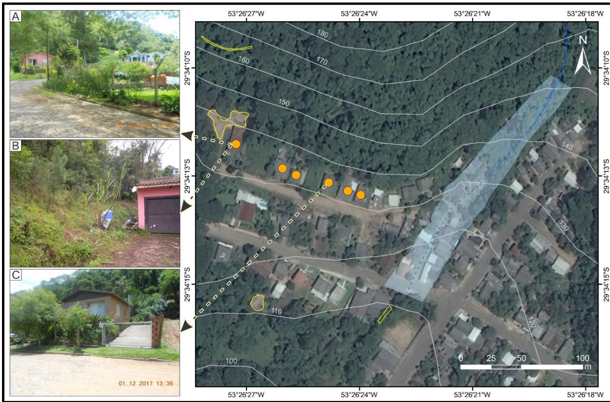
Figura 32 - Situação (V) de perigo alto em área próxima à base da encosta declivosa, com cortes e presença de árvores de grande porte isoladas (A, B e C).
