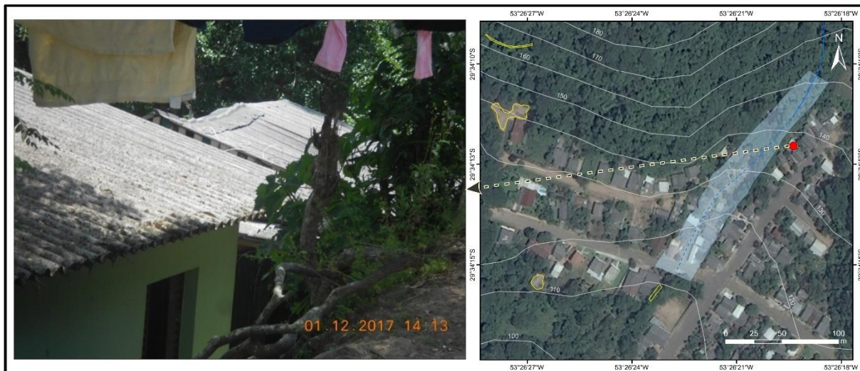
Figura 34 - Situação (I) de perigo muito alto em área com presença de cortes e aterros suscetível a escorregamentos.
