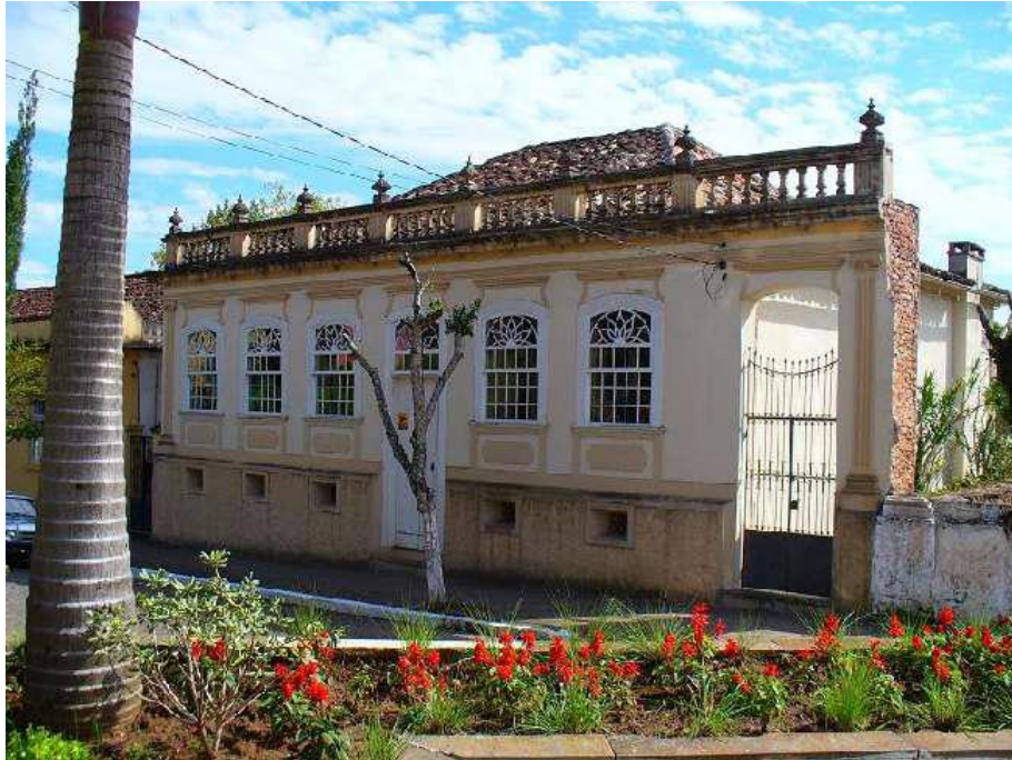
Figura 20: Prédio Magdala Fonte: Costa (2006, p.153)
