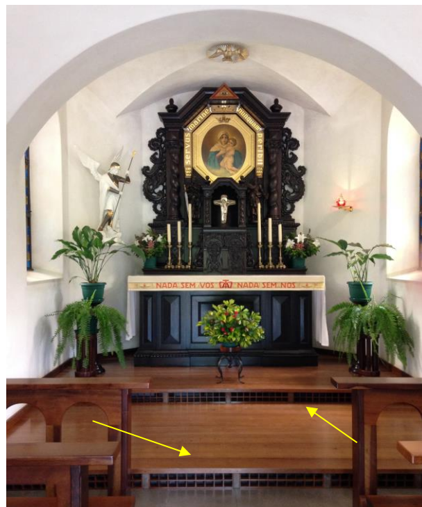
Figura 12 – Vista interna do altar da capela com destaque para as entradas de ar.
