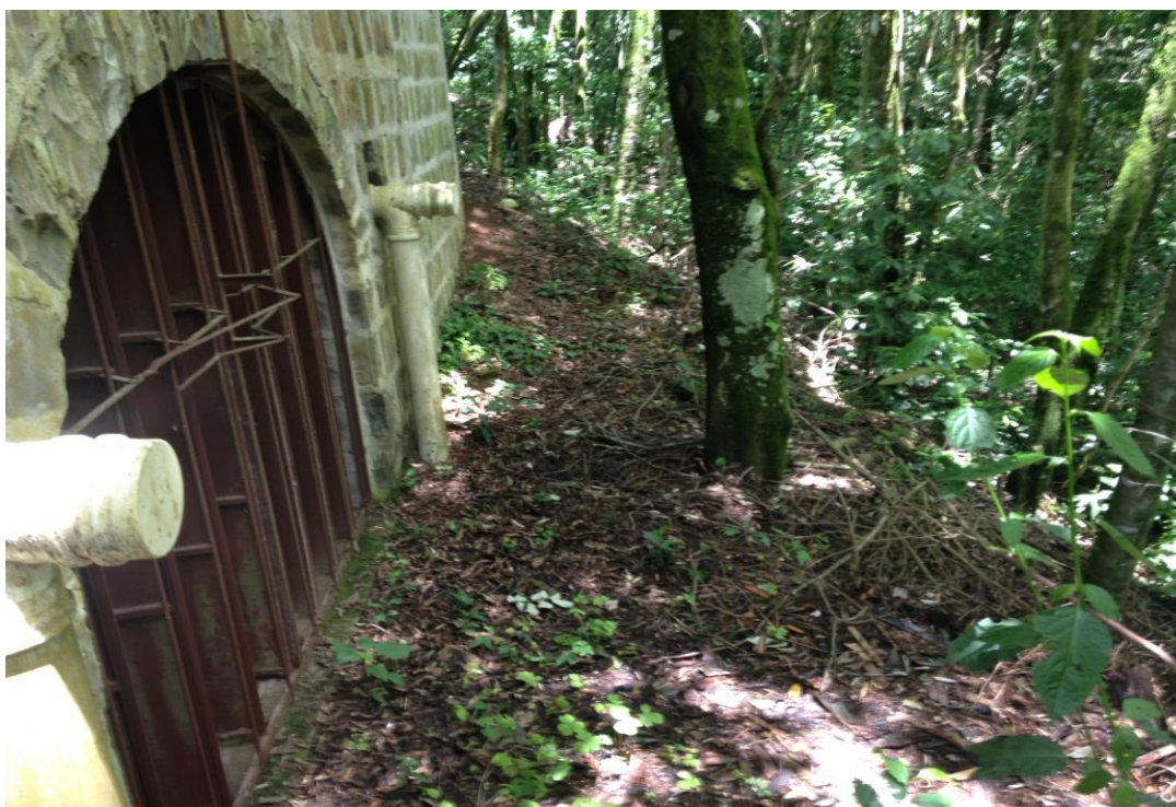
Figura 8- Entrada do duto enterrado da hospedaria.
