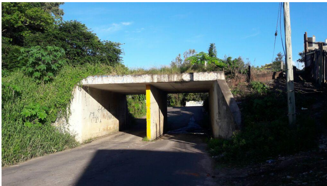
Figura 22: Foto geral da passagem inferior de acesso a Vila Waldemar Rodrigues
