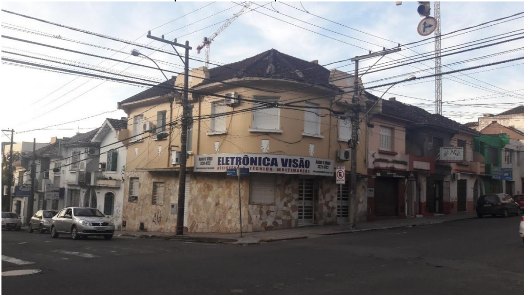
Figura 09: Casas em fita – Rua Duque de Caxias esquina com a Rua Venâncio Aires
