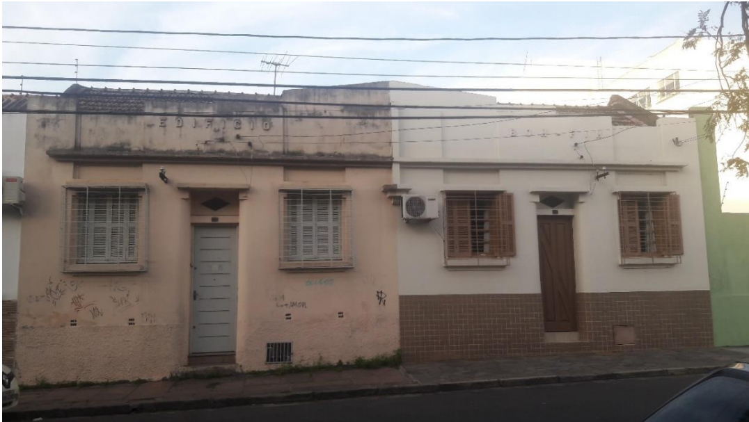
Figura 06: Edifício Bom-fim – Rua Barão do Triunfo
