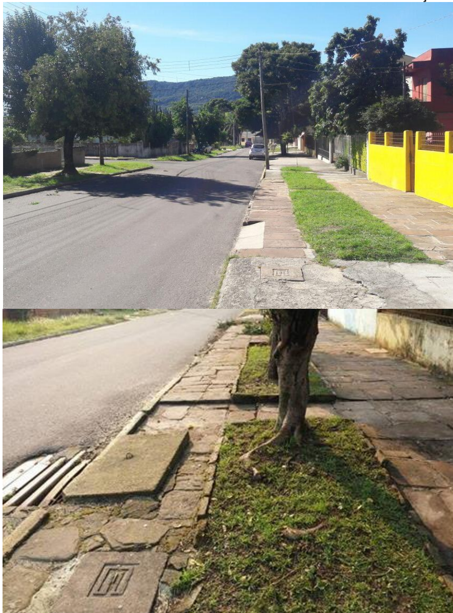
Figura 23: Alinhamento da rua com os elementos de infraestrutura urbana e circulação de pedestres
