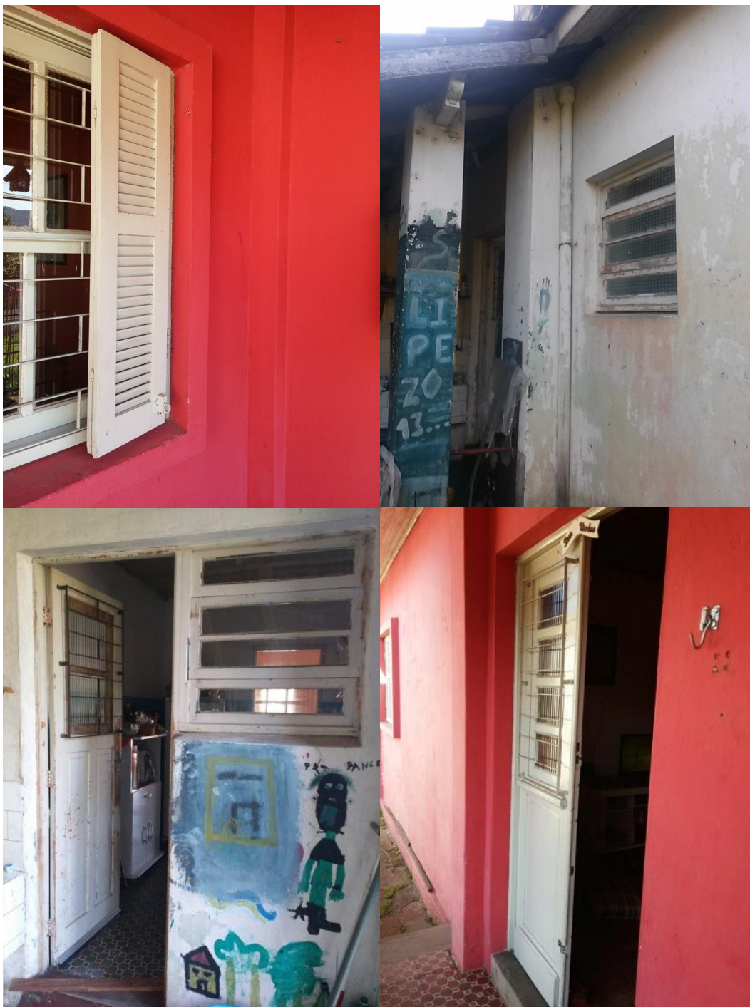
Figura 30, Figura 31, Figura 32 e Figura 33: Fotos das todos os tipos de esquadrias encontrados nas residências
