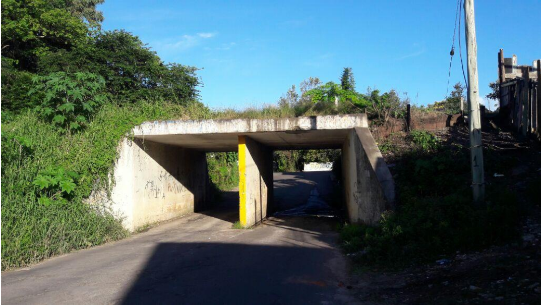
Figura 36: Foto geral da passagem inferior de acesso a Vila Waldemar Rodrigues
