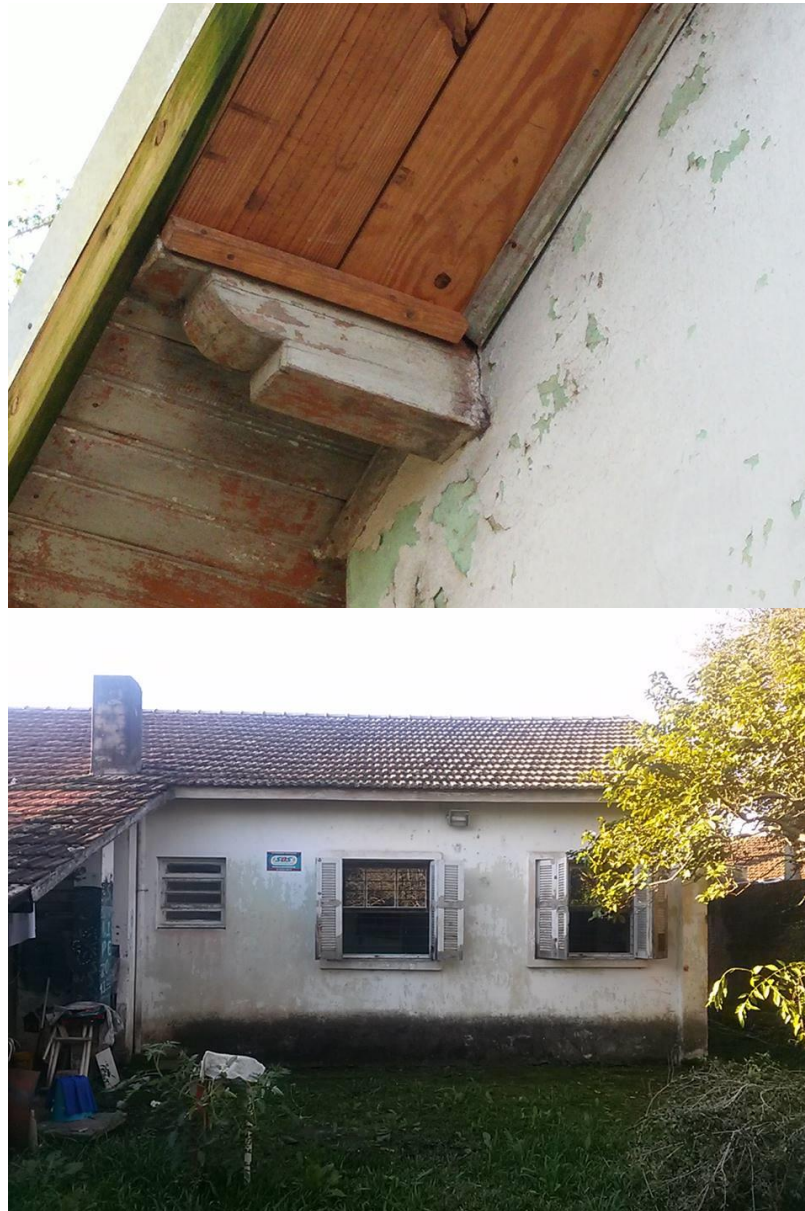
Figura 35: Fotos dos detalhes da chaminé e acabamentos externos da cobertura.
