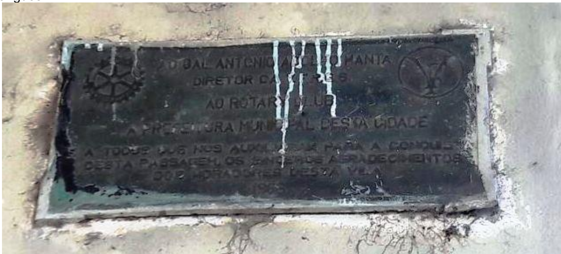
Figura 37: Foto da placa comemorativa instalada na passagem inferior de acesso a Vila Waldemar Rodrigues
