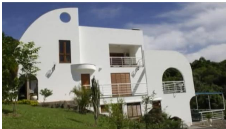
Figura 17: Detalhes da arquitetura dos prédios. Residência particular
