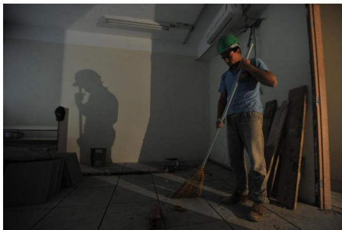
Figura 33 – Reforma subsolo Museu de Arte de Santa Maria, 2012
