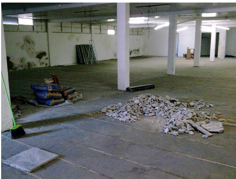
Figura 30 – Reforma do Museu de Arte de Santa Maria, troca do piso, 2010
