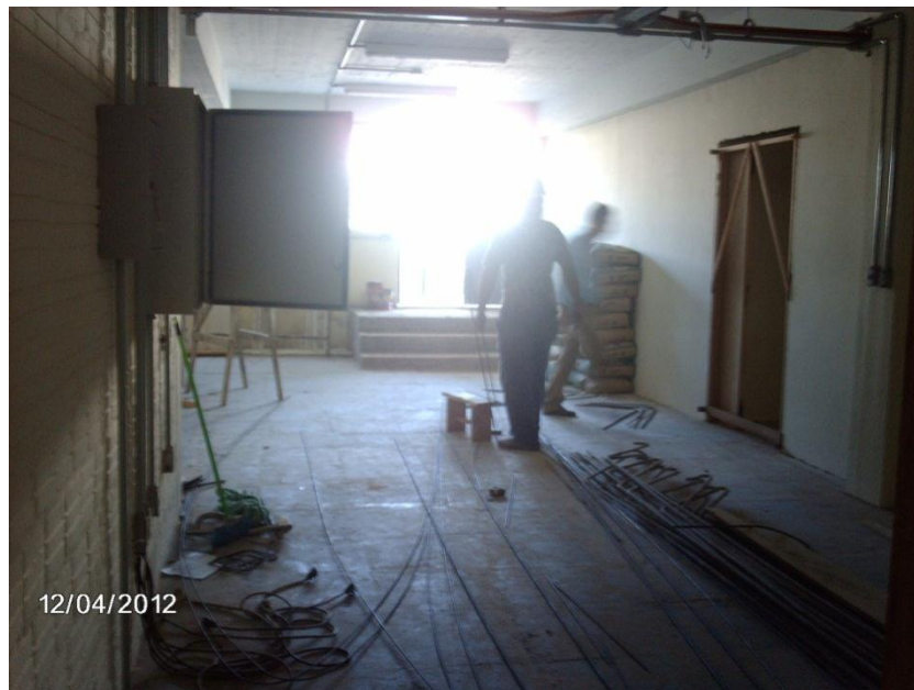
Figura 34 - Reforma subsolo Museu de Arte de Santa Maria, 2012
