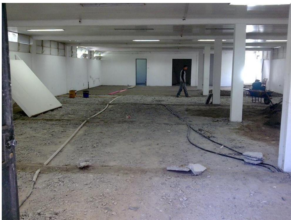
Figura 31- Reforma do Museu de Arte de Santa Maria, troca do piso, 2010
