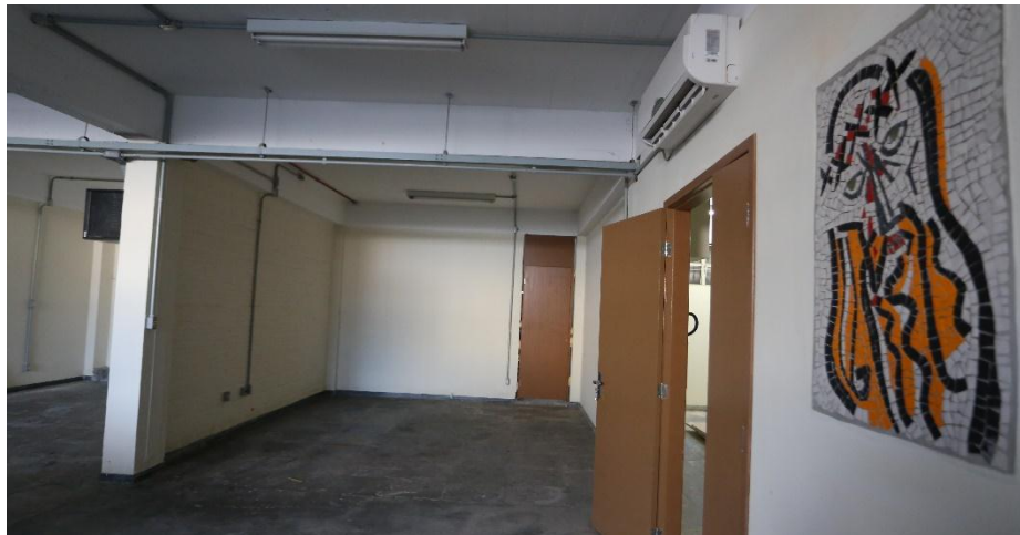
Figura 35 - Reforma subsolo Museu de Arte de Santa Maria, 2012
