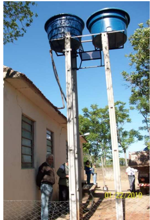
FIGURA A 2: Caixas de água da escola São João Batista em Formigueiro e com é realizado o abastecimento. Maio de 2009.
