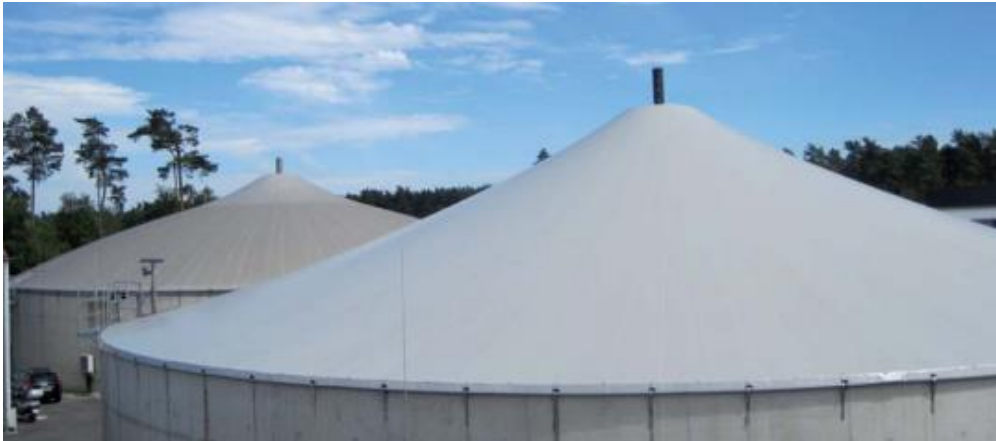
Figura 3.16 - bioESS com Membrana em Teto Intermediário acima do Biodigestor
