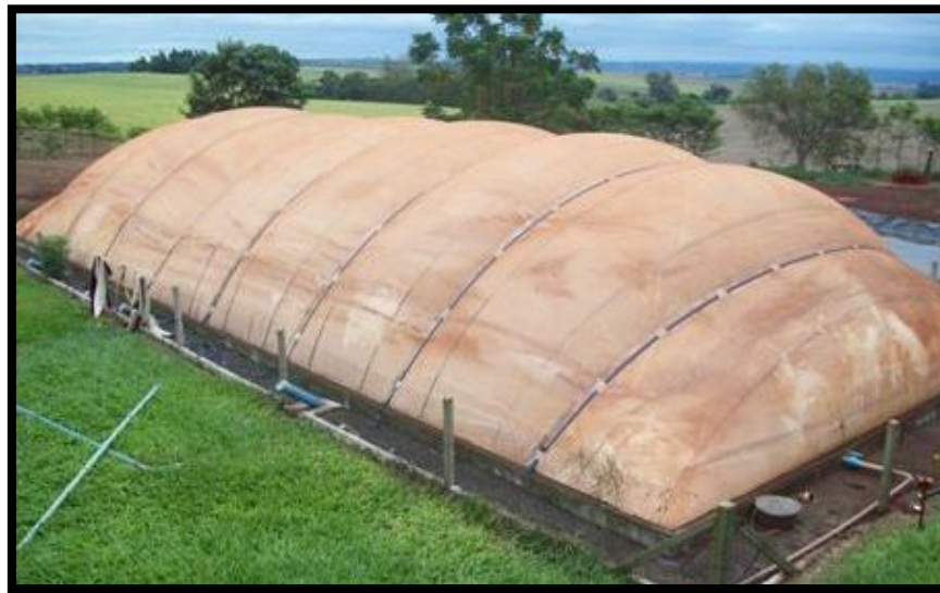
Figura 3.10 – bioESS com Biodigestor de Fluxo Tubular
