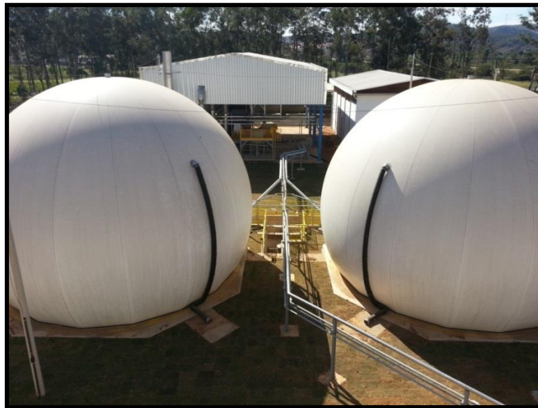
Figura 3.13 - bioESS Independente de Dupla Membrana
