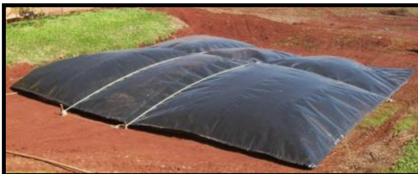
Figura 3.11 – bioESS Tipo Balão Independente
