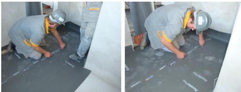
Figura 42 – Aplicação da fita adesiva
