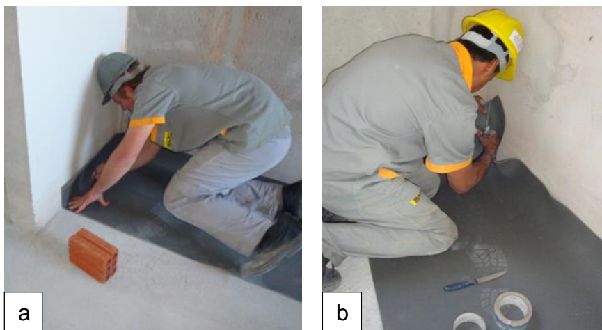
Figura 39 – Elevação da manta sobre a parede (a) e corte diagonal na manta (b)
