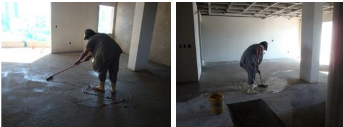
Figura 37 – Regularização da laje
