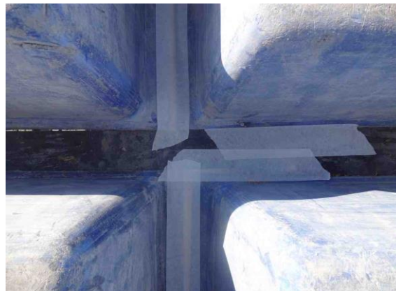
Figura 18 – Detalhe da fita crepe aplicada entre as frestas
