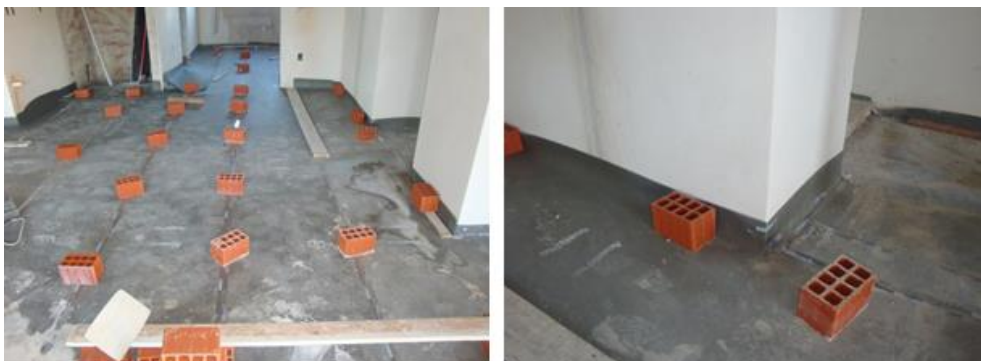
Figura 43 – Contrapeso na manta
