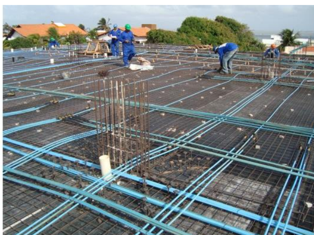
Figura 29 – Vista de laje com cabos de protensão sendo distribuídos
