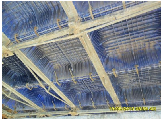
Figura 17 – Detalhe dos grampos entre alvéolos
