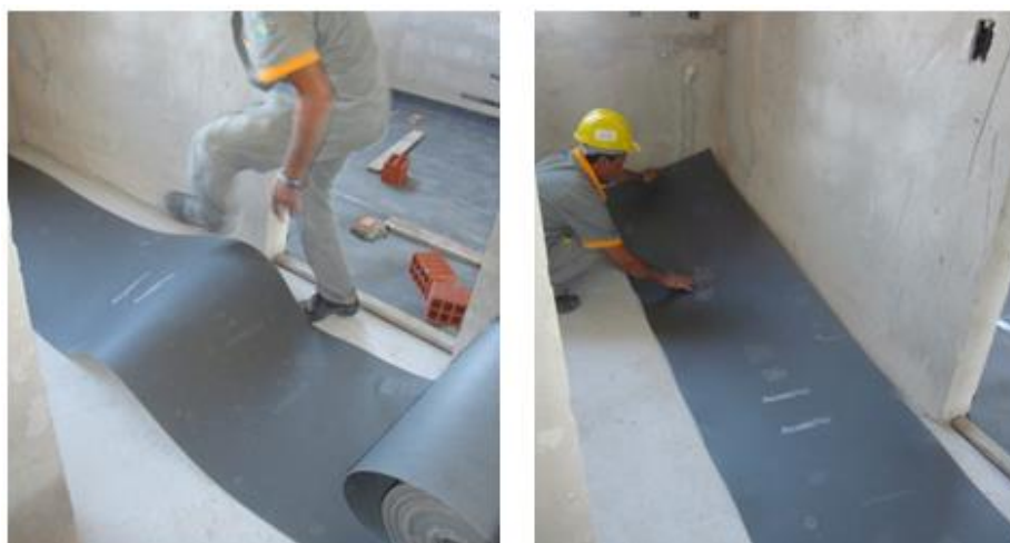
Figura 38 – Posicionamento do material resiliente
