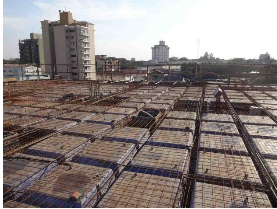
Figura 16 – Laje lisa nervurada apoiada diretamente sobre os pilares (visualização superior)
