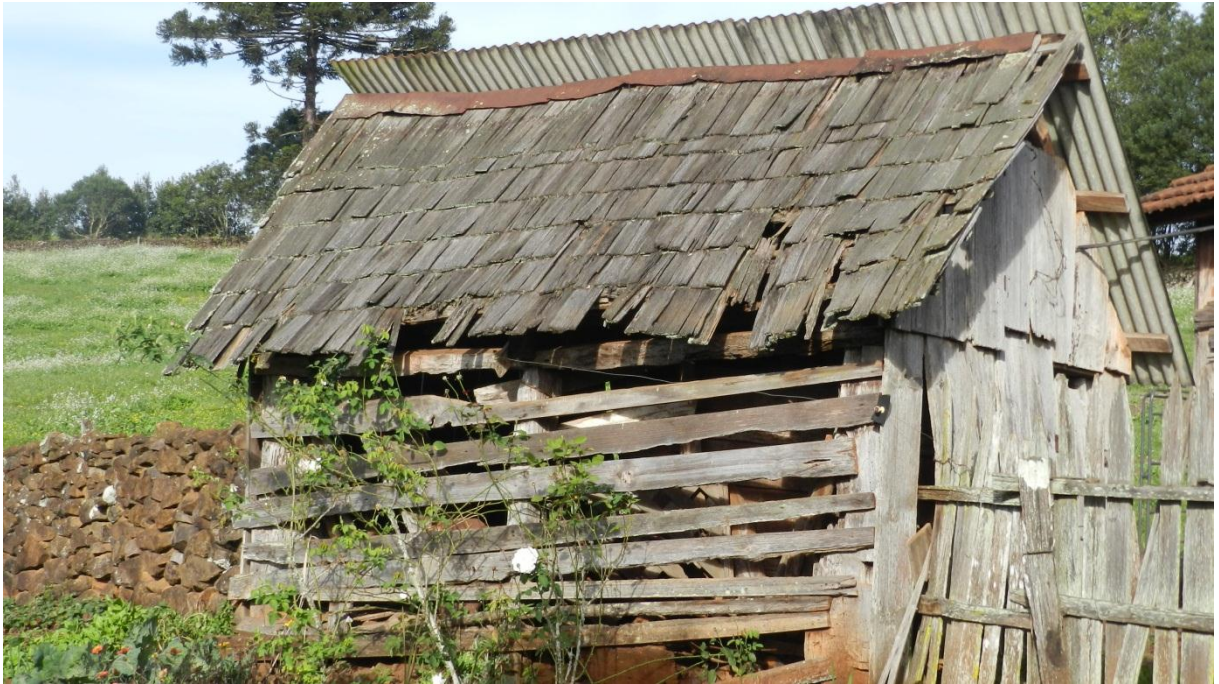
Figura 9 – Resquícios de uma construção de madeira com técnica Blocause
