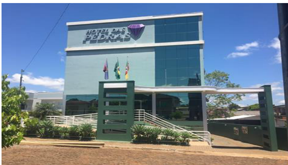
Figura 18 – Hotel das Pedras
