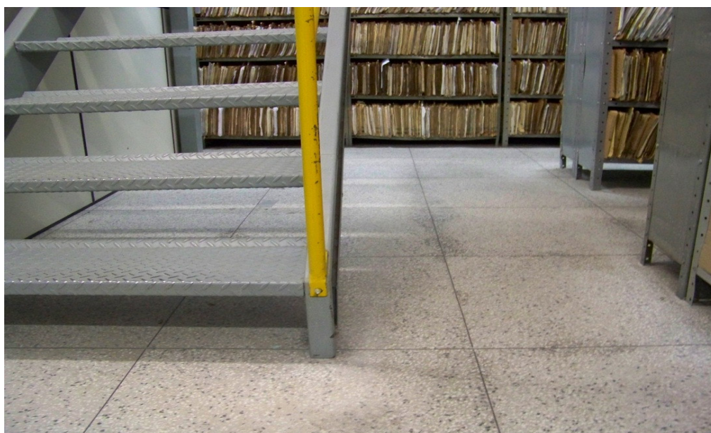
Figura 8: Piso do arquivo médico concreto com granitina Fonte: Arquivo. R.S.
