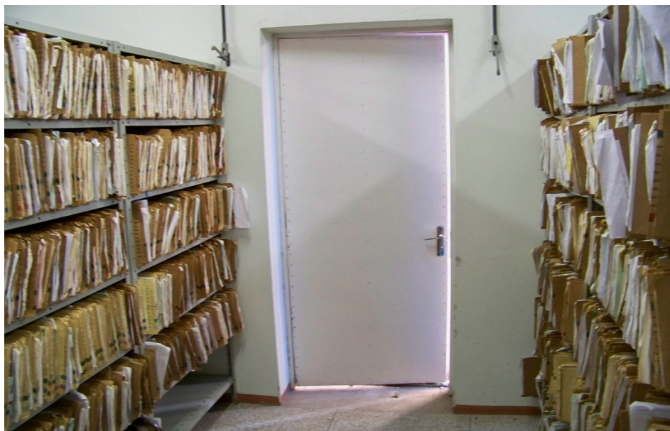
Figura 10: Porta corta fogo para saída de emergência Fonte: Arquivo R. S.
