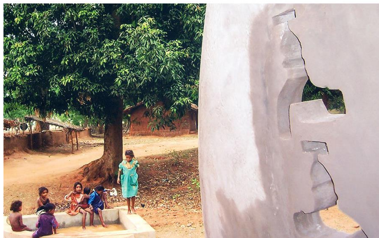
Figura 2 - Detalhe da estrutura criada para acesso à água Kondagaon, Bastar, Índia, 2005.
