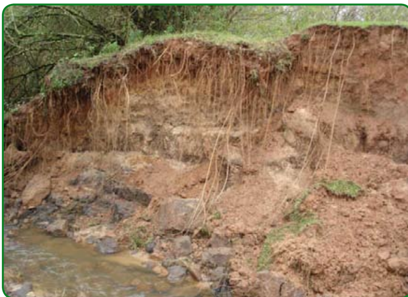
Figura 2.3 - Solapamento da margem de curso hídrico devido à retirada da cobertura vegetal (Foto: A. P. M. Rovedder, 2007).
