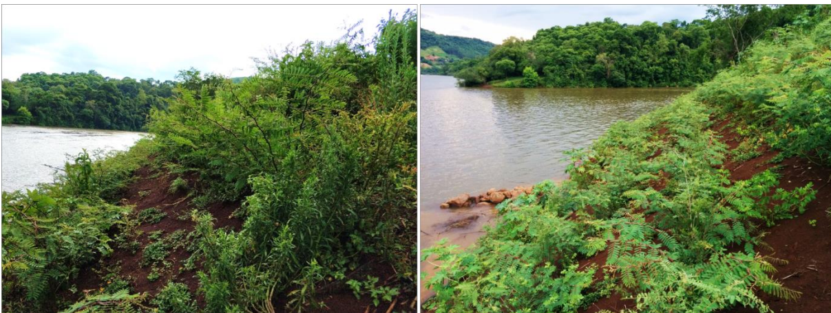
Figura 60 - Aspecto geral da área de intervenção 3 meses após execução das técnicas de Engenharia Natural (vista para montante).
