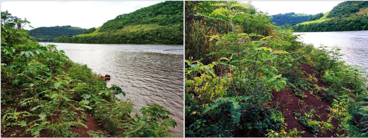
Figura 59 - Aspecto geral da área de intervenção 3 meses após execução das técnicas de Engenharia Natural (vista para jusante).
