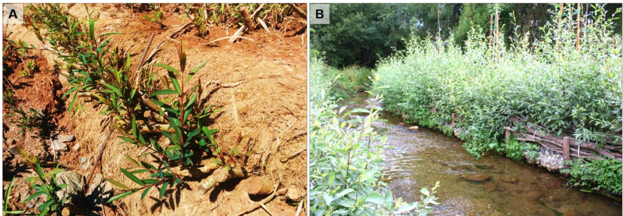
Figura 3 - Exemplo de duas técnicas de estabilização. Intervenção com biorretentores de coco com estacas vivas (A). Intervenção de feixes vivos combinados com gabião cilíndrico (B).
