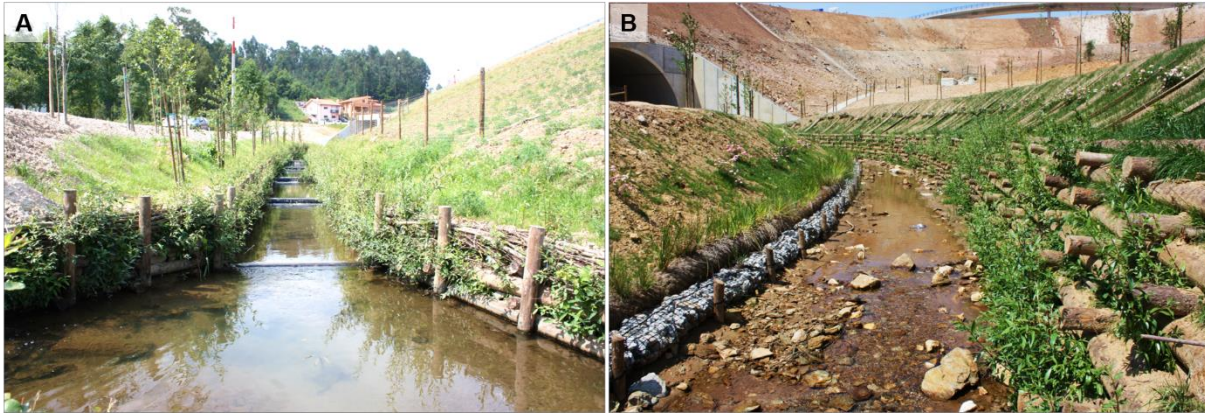
Figura 4 - Exemplo de duas técnicas de consolidação. Intervenção composta por muro de suporte vivo (parede krainer) fluvial com prumo frontal (A). Intervenção composta por muro de suporte vivo (parede krainer) parede dupla (B).
