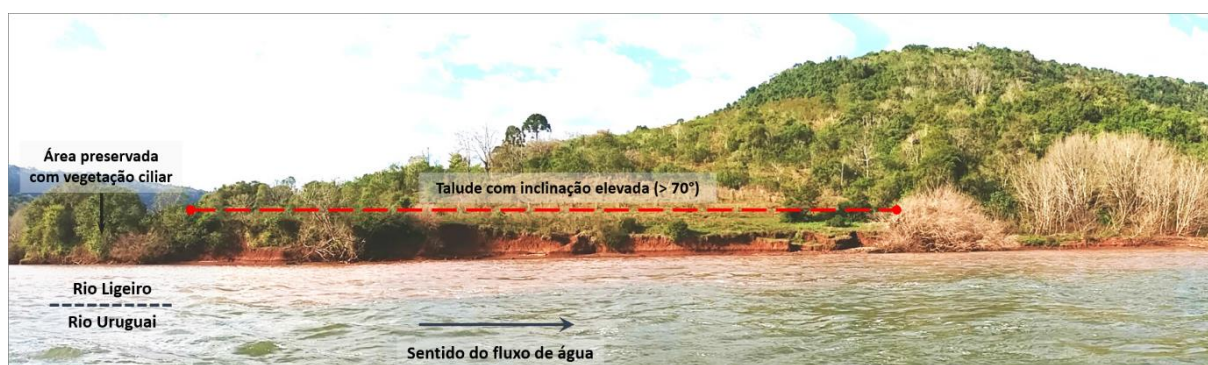
Figura 33 - Vista frontal da área de intervenção em julho de 2016 (fotografia sem escala).
