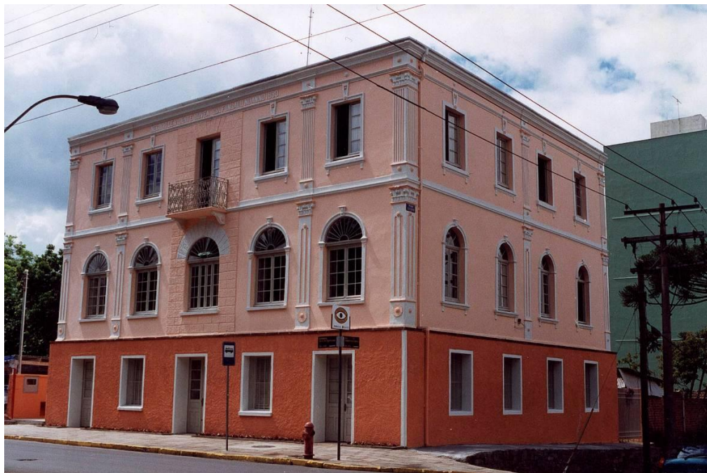
ILUSTRAÇÃO 5 - Prédio do Arquivo Histórico Municipal João Spadari Adami. Fonte: o mesmo.
