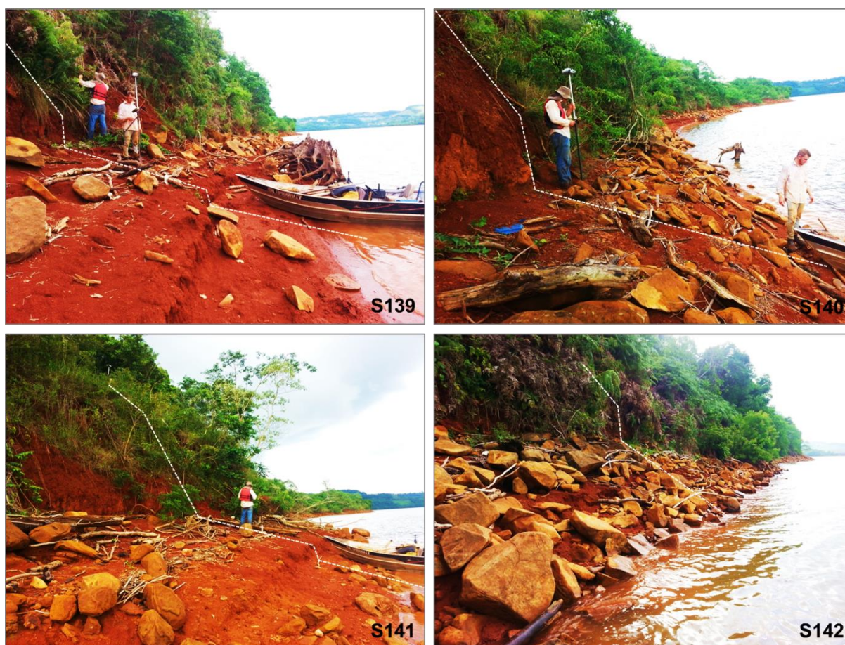
Figura 55 – Fisionomia geral dos subtrechos de abrangência das quatro seções topográficas (S139 a S142) escolhidas para a análise dos processos erosivos após duas campanhas de monitoramento.
