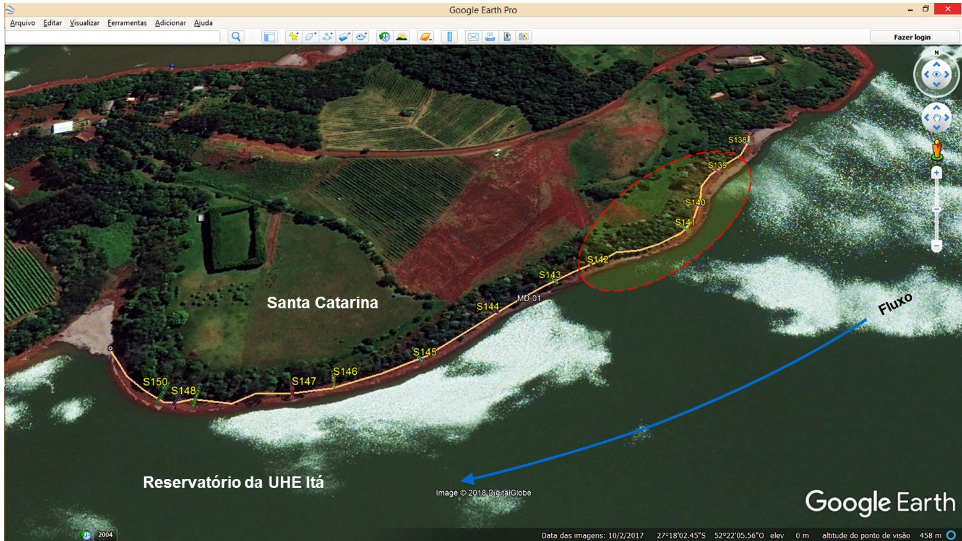
Figura 54 – Vista geral do trecho MD-01 contendo as seções topográficas utilizadas para avaliação de processos erosivos e validação da metodologia.
