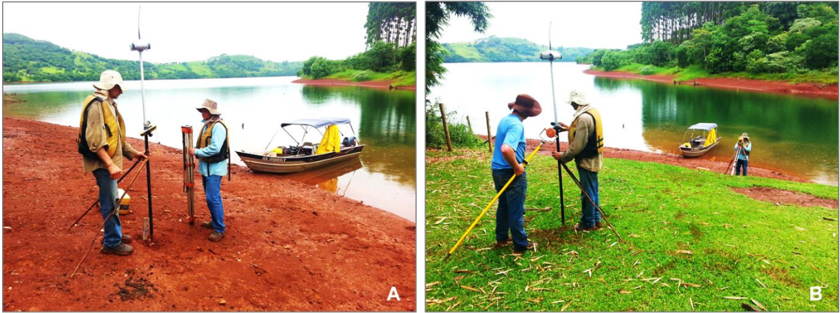
Figura 34 – (A) transporte de coordenadas geográficas (X, Y) e cota altimétrica (Z) com sistema RTK até o local de implantação da seção topográfica (a estação móvel está posicionada sobre o piquete) e (B) coleta de primeiro ponto topográfico no terreno natural para determinação do alinhamento ortogonal da seção em relação às curvas de nível do terreno e à cota máxima do reservatório.
